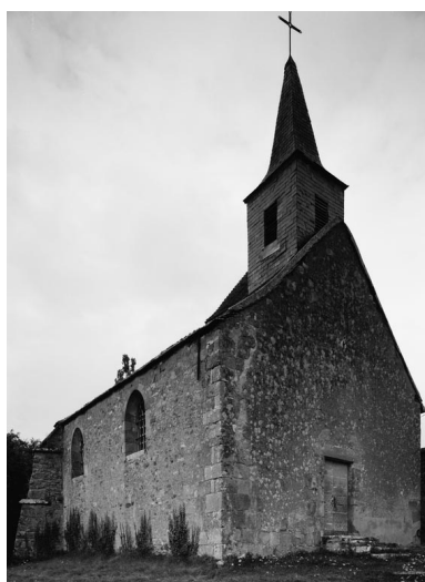
Vue d'ensemble de 3/4 droit (photo prise en 1978). Phot. Michel Thierry IVR26_19782100768V
