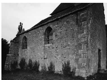
Élévation droite (photo prise en 1978). Phot. Michel Thierry IVR26_19782100770V
