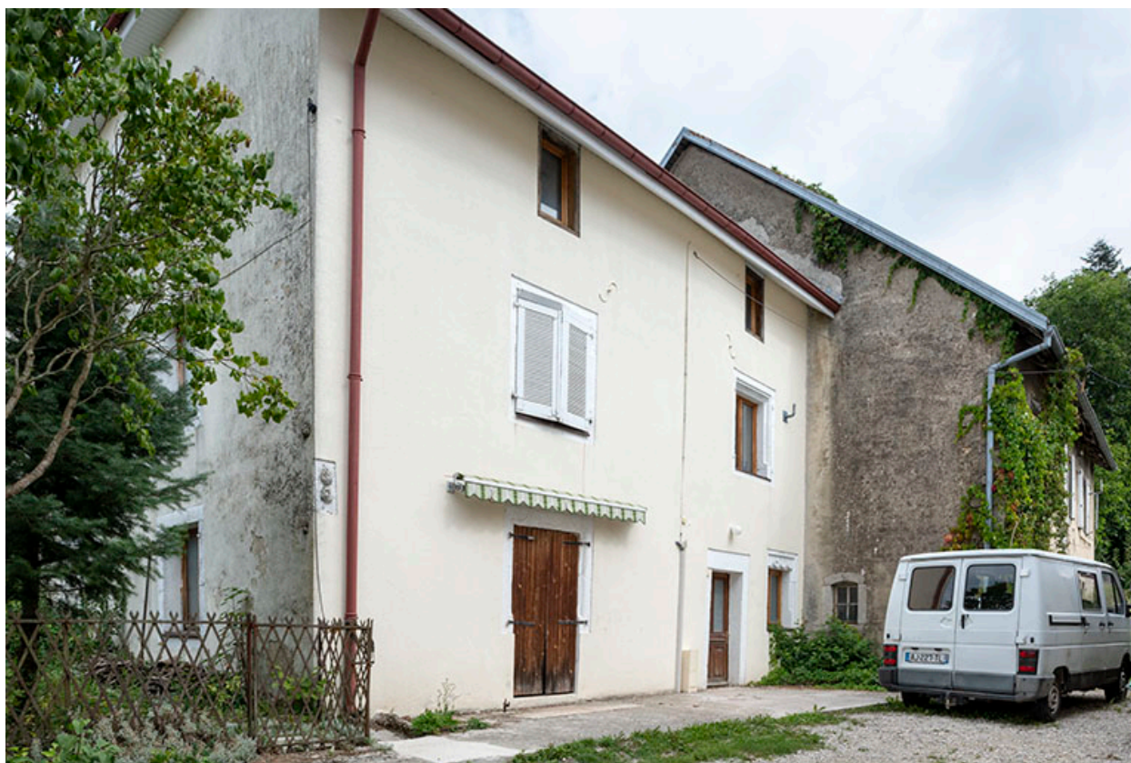
Bâtiment de 1723 : façade antérieure, de trois quarts.
