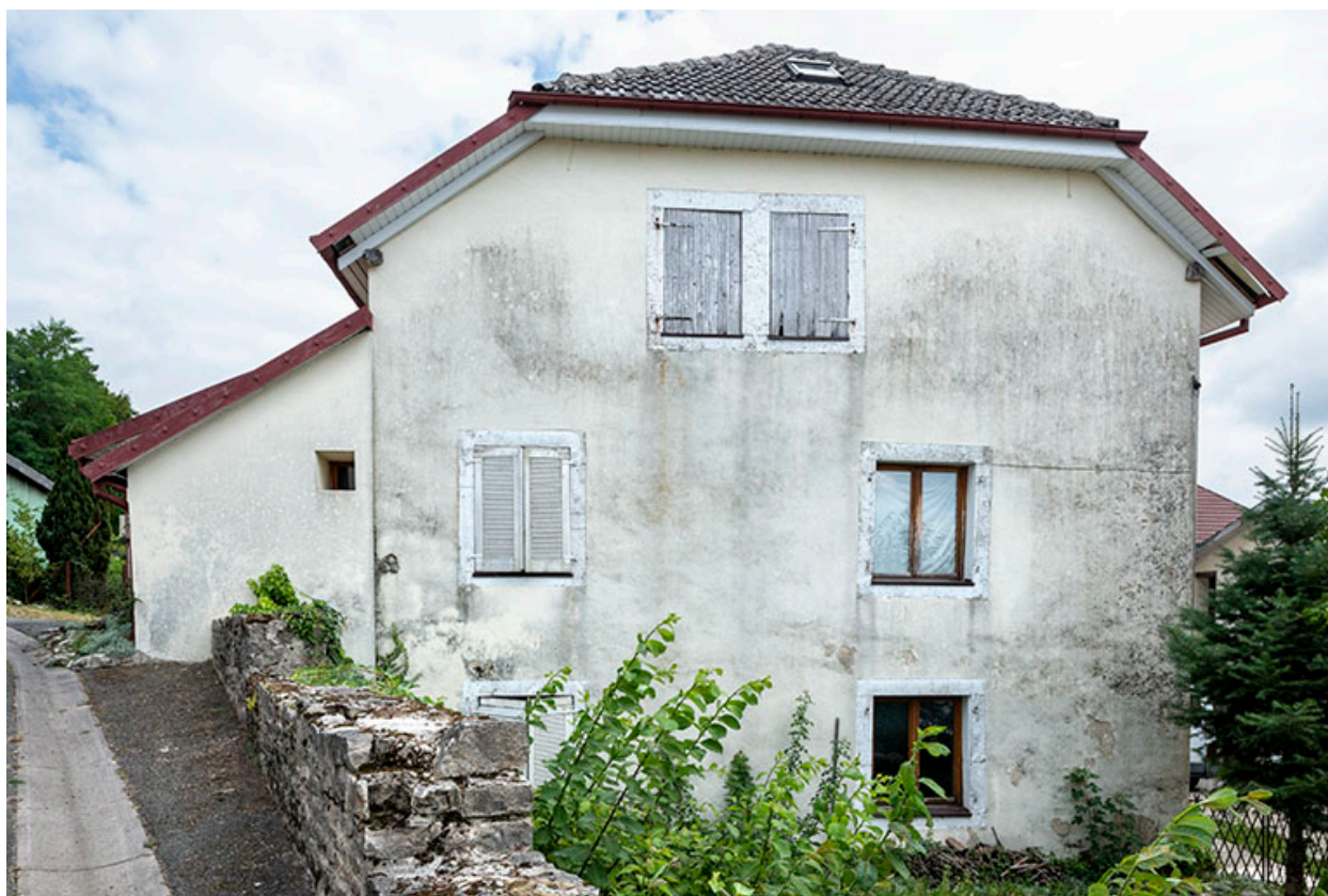
Bâtiment de 1723 : façade latérale gauche.
