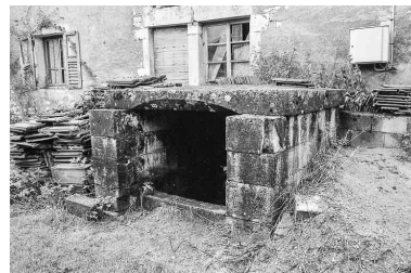
Détail de la fontaine. Phot. Bernard Lardière IVR43_19817000282Z
