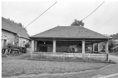
Vue d'ensemble. Phot. Bernard Lardière IVR43_19817000280Z
