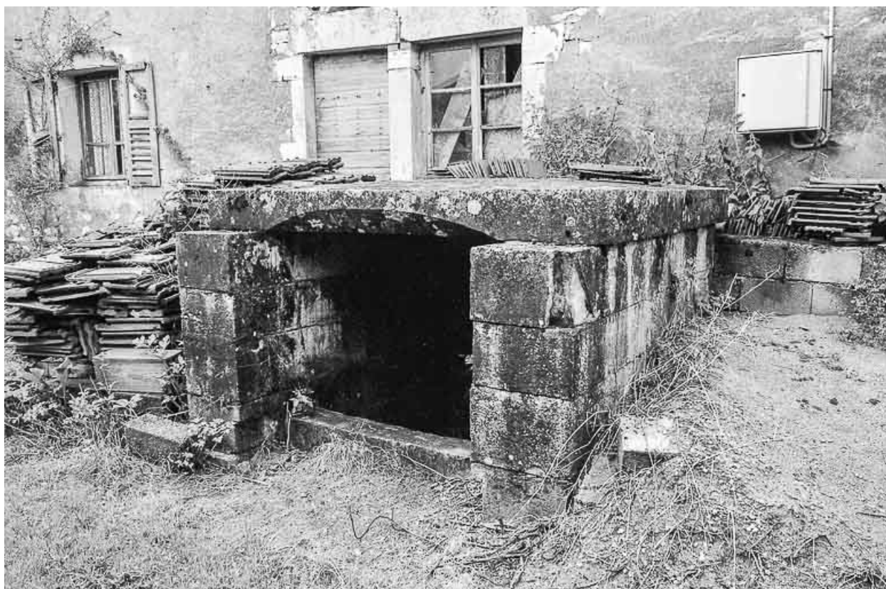
Détail de la fontaine.
