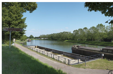
Vue de la cale. Phot. Thierry Kuntz IVR26_20135800351NUC4A
