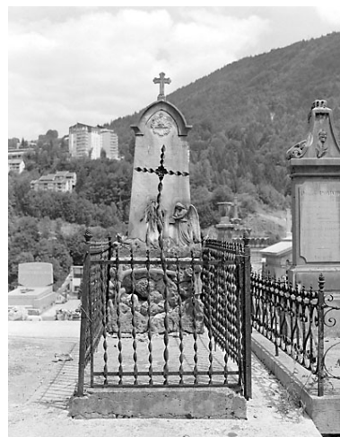
Vue d'ensemble, de face : grille de clôture.
