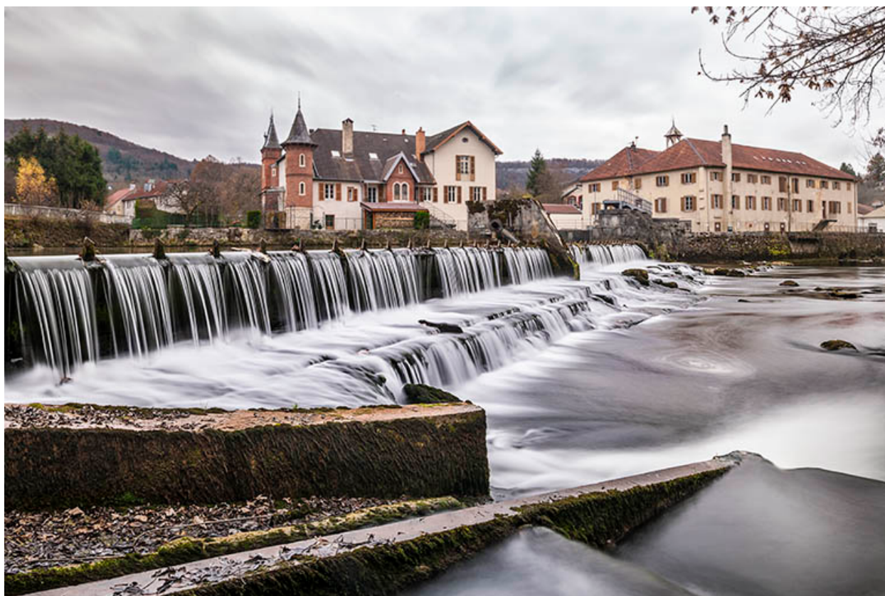
Usine de petite métallurgie Rivex depuis la rive droite de la Loue, à Ornans.
