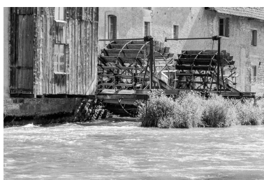
Roues hydrauliques suspendue sur la Loue, à Ornans.
