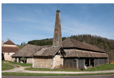
Tuilerie de la Combe de Punay, à Malbrans.
