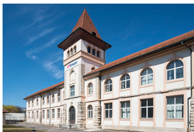
Usine de petite métallurgie Schrader, à Pontarlier. Phot. Jérôme Mongreville IVR43_20172500332NUC4A
