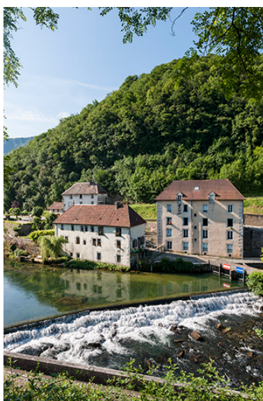
Logements et dépendances de l'usine métallurgique de Lods. Phot. Jérôme Mongreville IVR43_20152501508NUC4A
