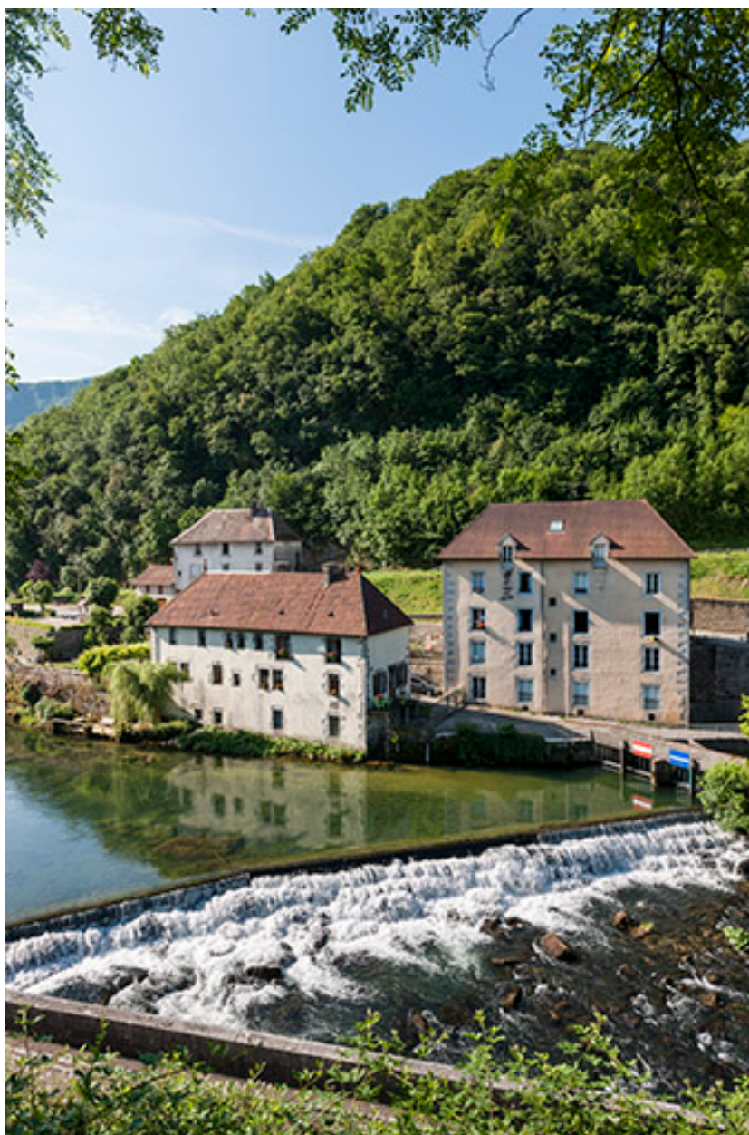
Logements et dépendances de l'usine métallurgique de Lods.
