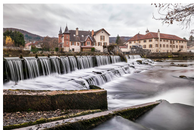
Usine de petite métallurgie Rivex depuis la rive droite de la Loue, à Ornans. Phot. Jérôme Mongreville IVR43_20152502536NUC4A
