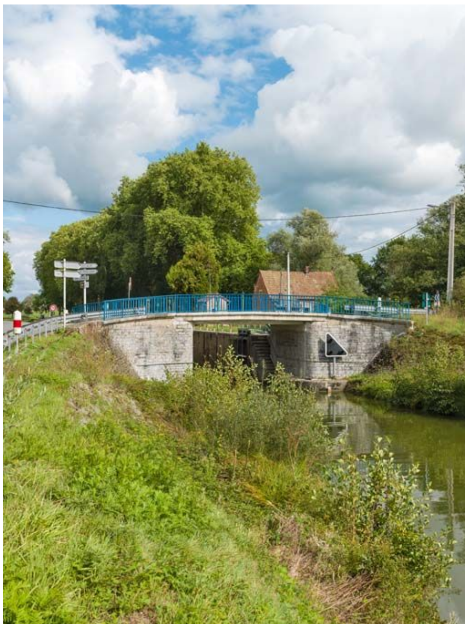
Vue d'ensemble du pont.
