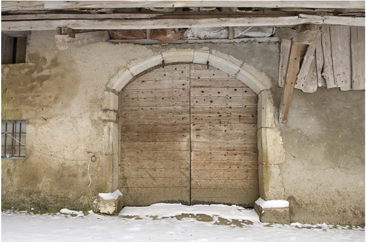
Façade postérieure : porte de grange.
