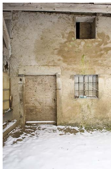
Façade postérieure : porte. Phot. Jérôme Mongreville IVR43_20082500971NUC2A
