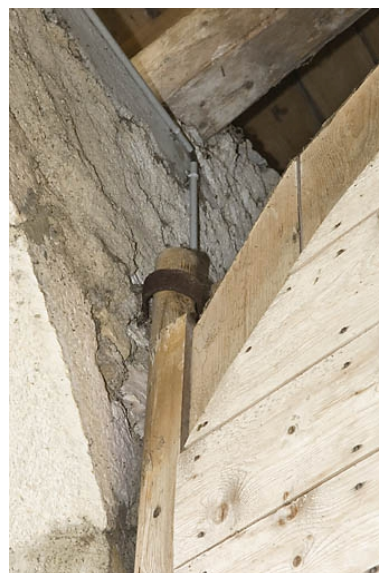
Façade postérieure, porte de grange : gond supérieur du vantail de gauche. Phot. Jérôme Mongreville IVR43_20082500961NUC2A
