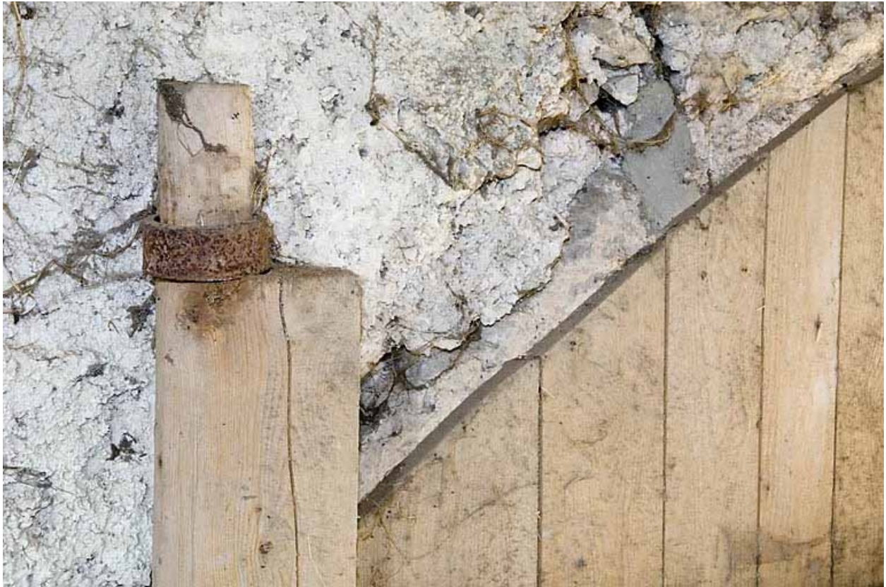
Façade postérieure, porte de grange : gond supérieur du vantail de droite.
