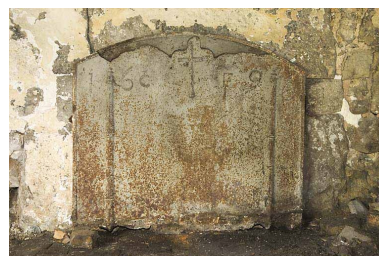
Plaque de cheminée portant la date 1696. Phot. Jérôme Mongreville IVR43_20082500959NUC2A
