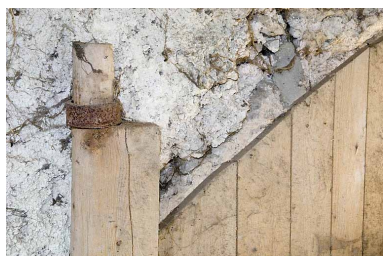
Façade postérieure, porte de grange : gond supérieur du vantail de droite. Phot. Jérôme Mongreville IVR43_20082500962NUC2A
