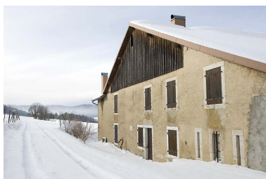
Façade latérale droite, en hiver. Phot. Jérôme Mongreville IVR43_20082500972NUC2A
