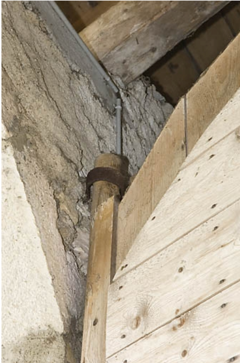
Façade postérieure, porte de grange : gond supérieur du vantail de gauche.
