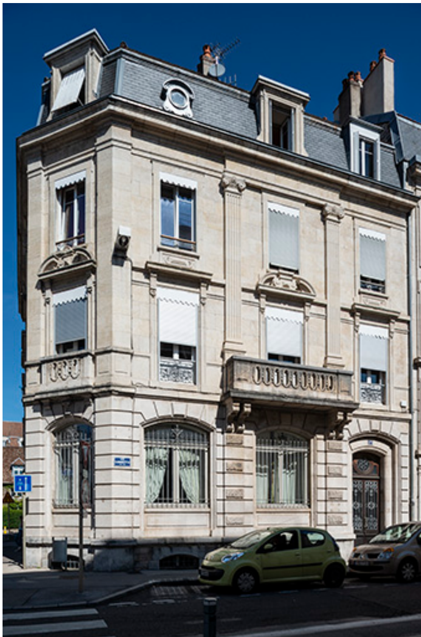
Façade sur la rue Gambetta (n°17).
