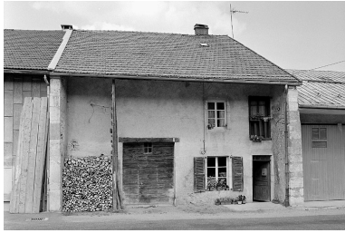
Façade sur rue. Phot. Jérôme Mongreville IVR43_19943900791X
