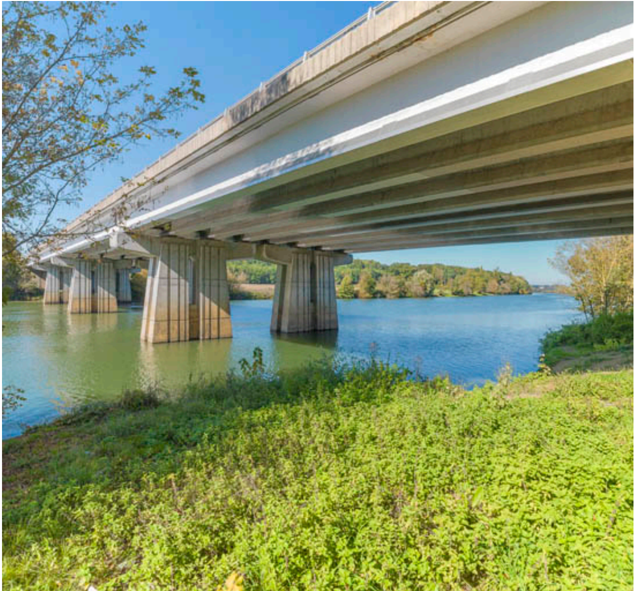
Vue rapprochée des piles et du tablier.
