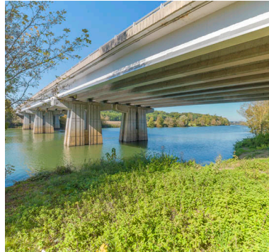
Vue rapprochée des piles et du tablier. Phot. Thierry Kuntz IVR26_20172100523NUC4A
