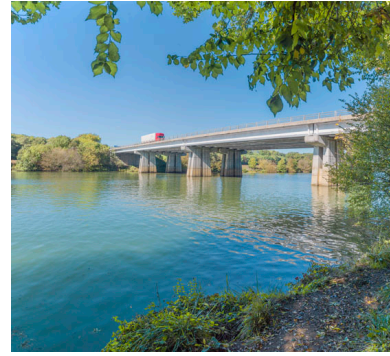
Vue d'ensemble : passage d'un camion. Phot. Thierry Kuntz IVR26_20172100524NUC4A
