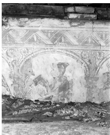
Comble de la nef, mur droit, 4e-5e travées : février Phot. Michel Thierry IVR26_19872100849X
