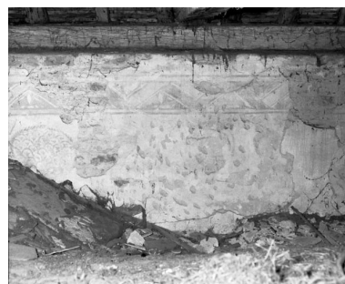
Comble de la nef, mur gauche, 4e-5e travées Phot. Michel Thierry IVR26_19872100853X
