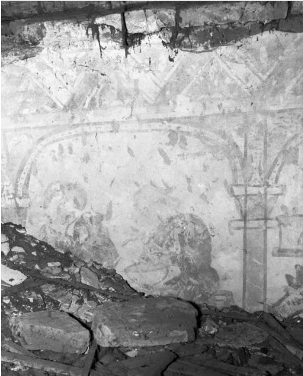
Comble de la nef, mur droit
