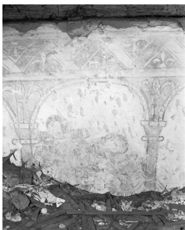
Comble de la nef, mur droit, 3e-4e travées : juillet Phot. Michel Thierry IVR26_19872100846X
