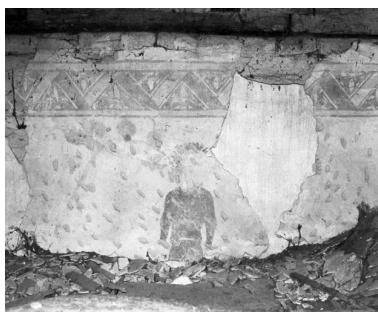
Comble de la nef, mur gauche, 3e-4e travées Phot. Michel Thierry IVR26_19872100852X
