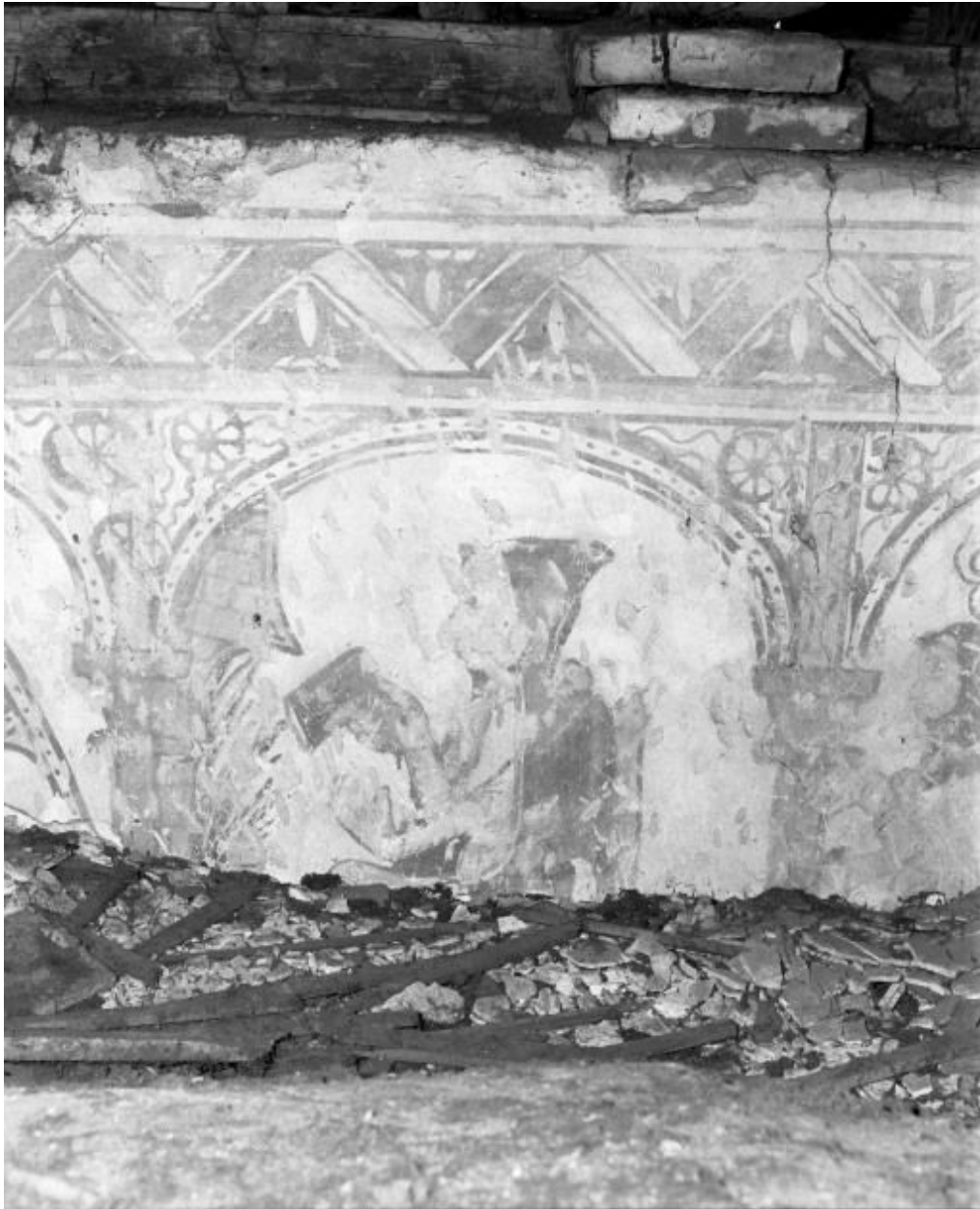
Comble de la nef, mur droit, 4e-5e travées : février
