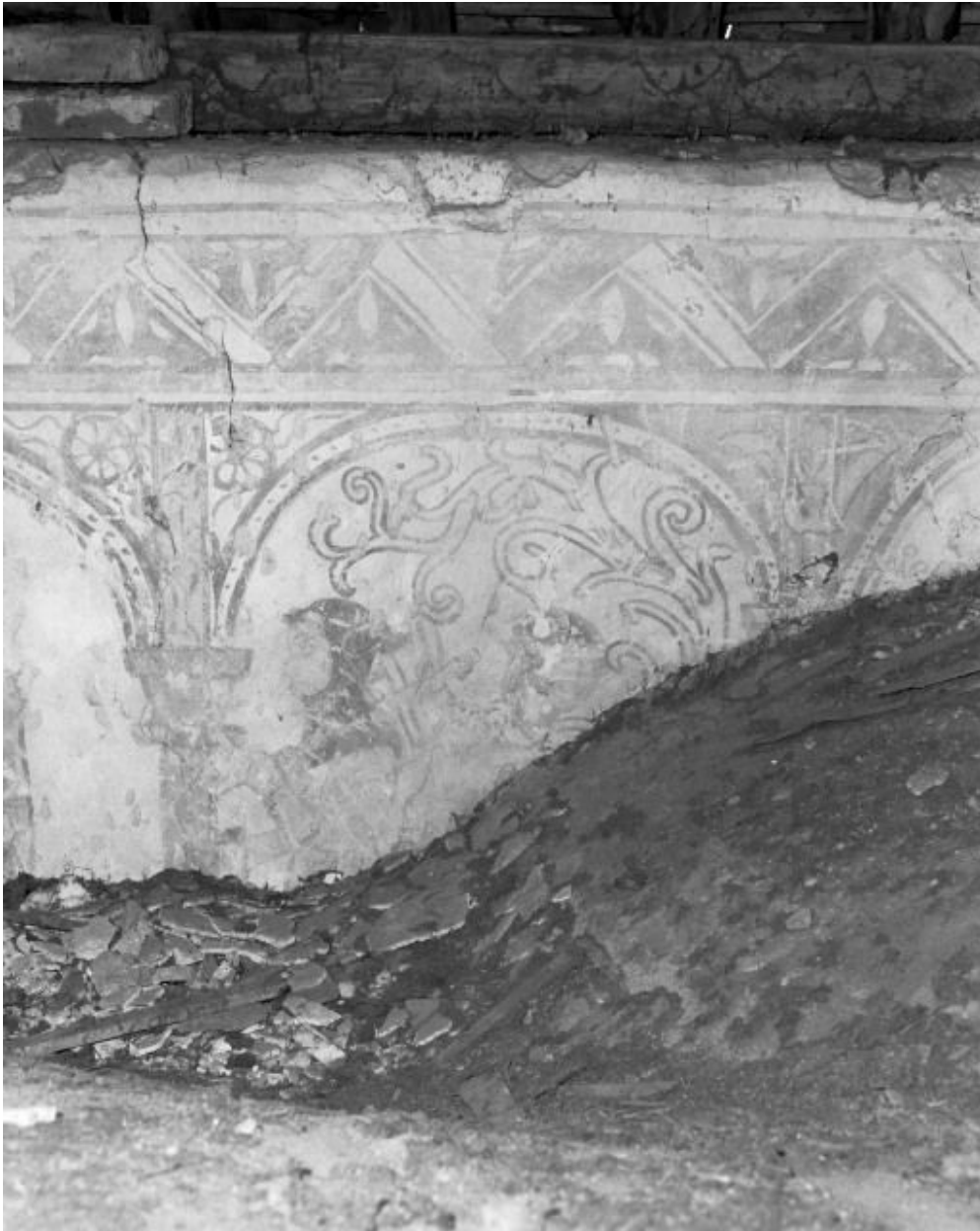
Comble de la nef, mur droit, 4e-5e travées : mars
