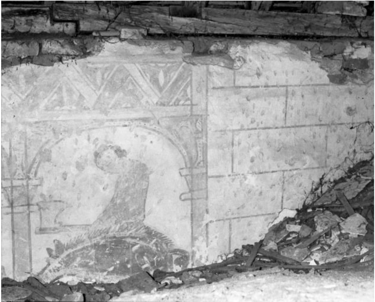
Comble de la nef, mur droit : décembre
