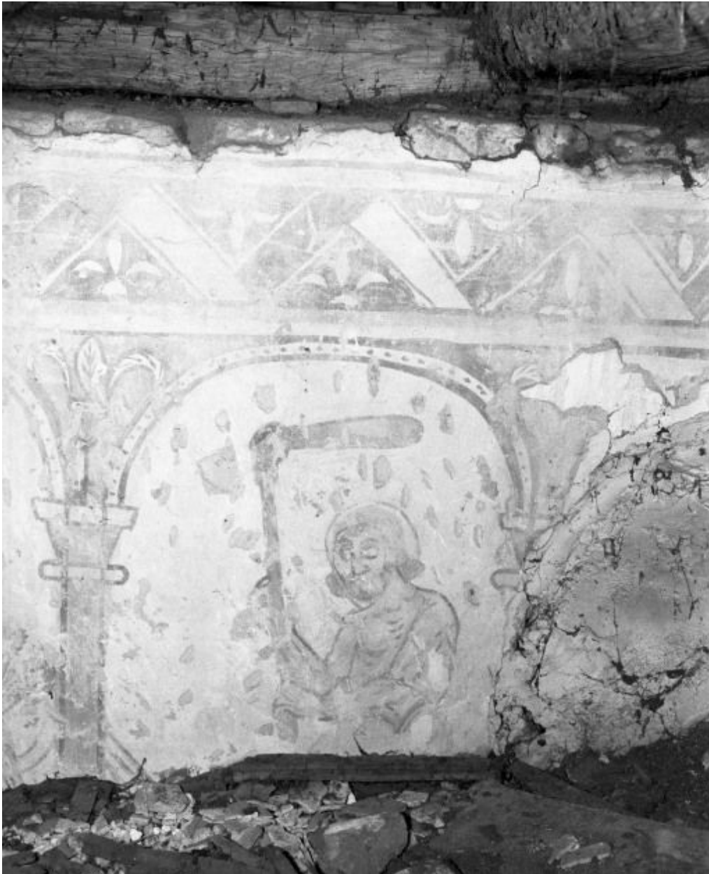
Comble de la nef, mur droit, 3e-4e travées : août
