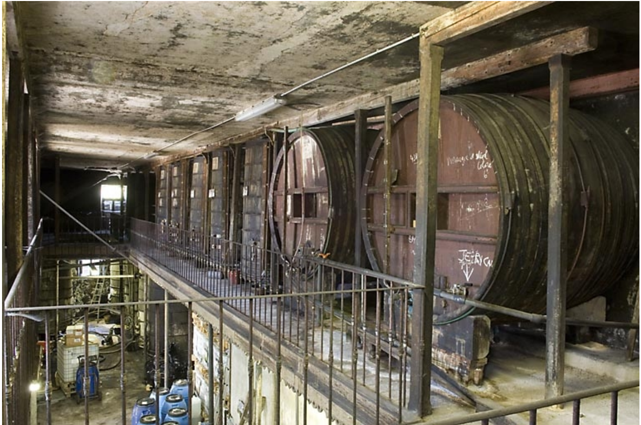
Etage de la cuverie (partie est).
