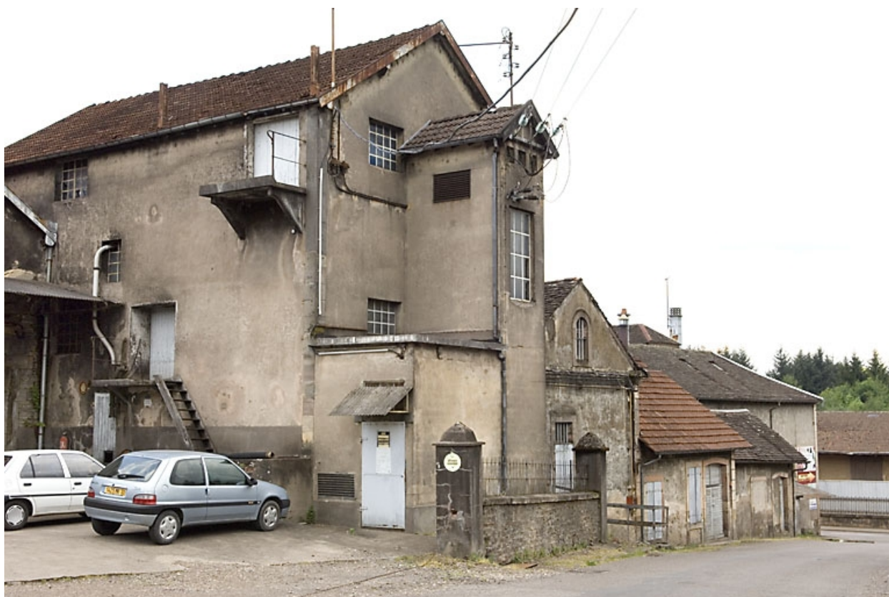
Façades sur la rue des Moines Hauts.
