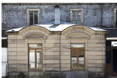
Bureaux. Mur sud de la cour. Phot. Jérôme Mongreville IVR43_20077000251NUCA
