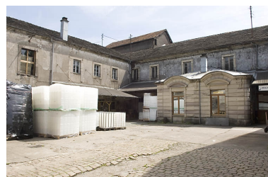
La cour vue depuis l'entrée. Phot. Jérôme Mongreville IVR43_20077000260NUCA
