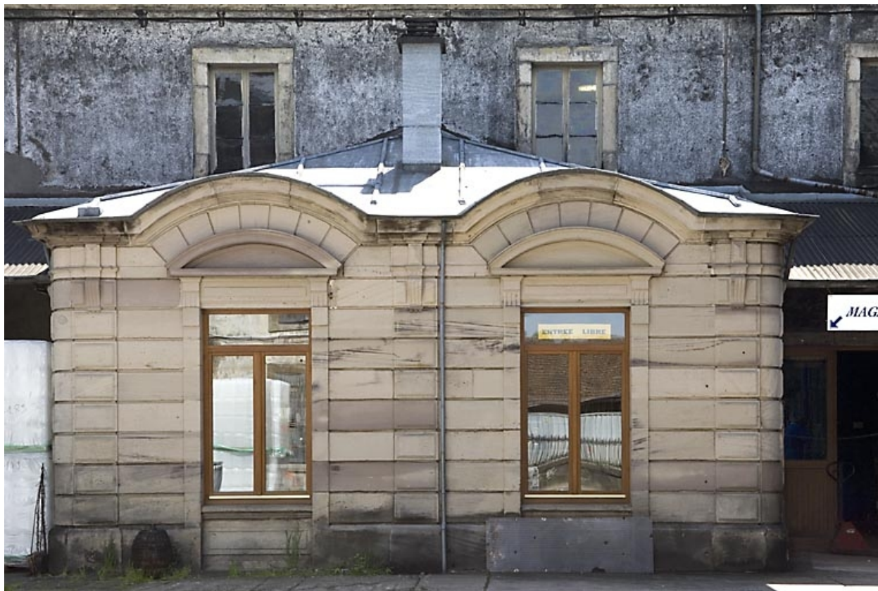
Bureaux. Mur sud de la cour.
