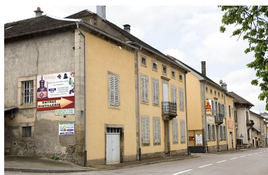
Bâtiments sur la rue de la Gare. Phot. Jérôme Mongreville IVR43_20077000246NUCA
