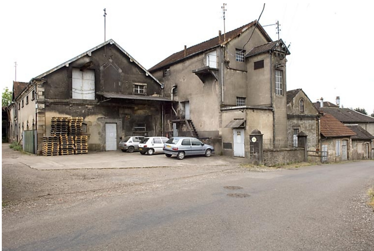
Ancienne écurie et cuverie. Vue depuis l'est.
