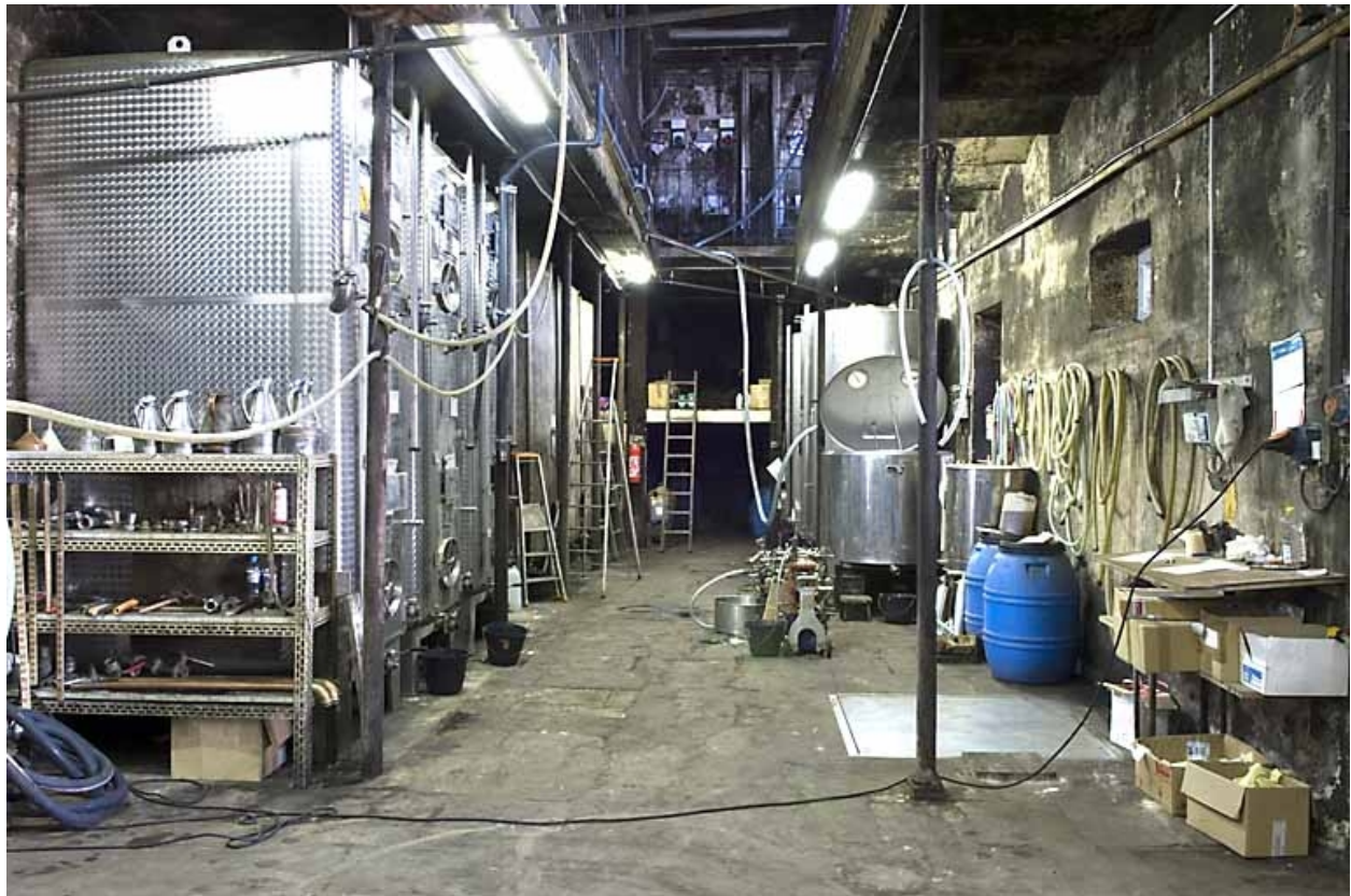
Cuverie. Installations récentes.
