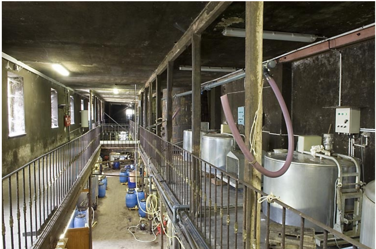
Etage de la cuverie. Vue d'ensemble.
