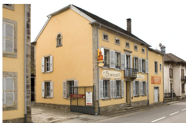
Bureaux et logement. Phot. Jérôme Mongreville IVR43_20077000248NUCA
