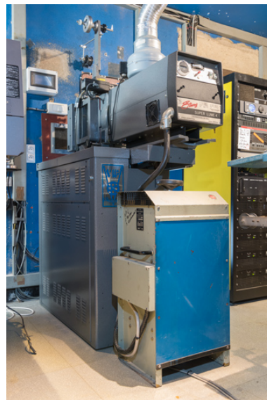
Projecteur Simplex et redresseur Prevost, de trois quarts arrière gauche. Phot. Pierre-Marie Barbe-Richaud IVR26_20257100376NUC4A
