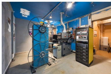
Vue d'ensemble de la cabine depuis l'entrée. Au centre l'enrouleur-dérouleur vertical Idef, le redresseur Prevost et le projecteur Simplex. Phot. Pierre-Marie Barbe-Richaud IVR26_20257100374NUC4A
