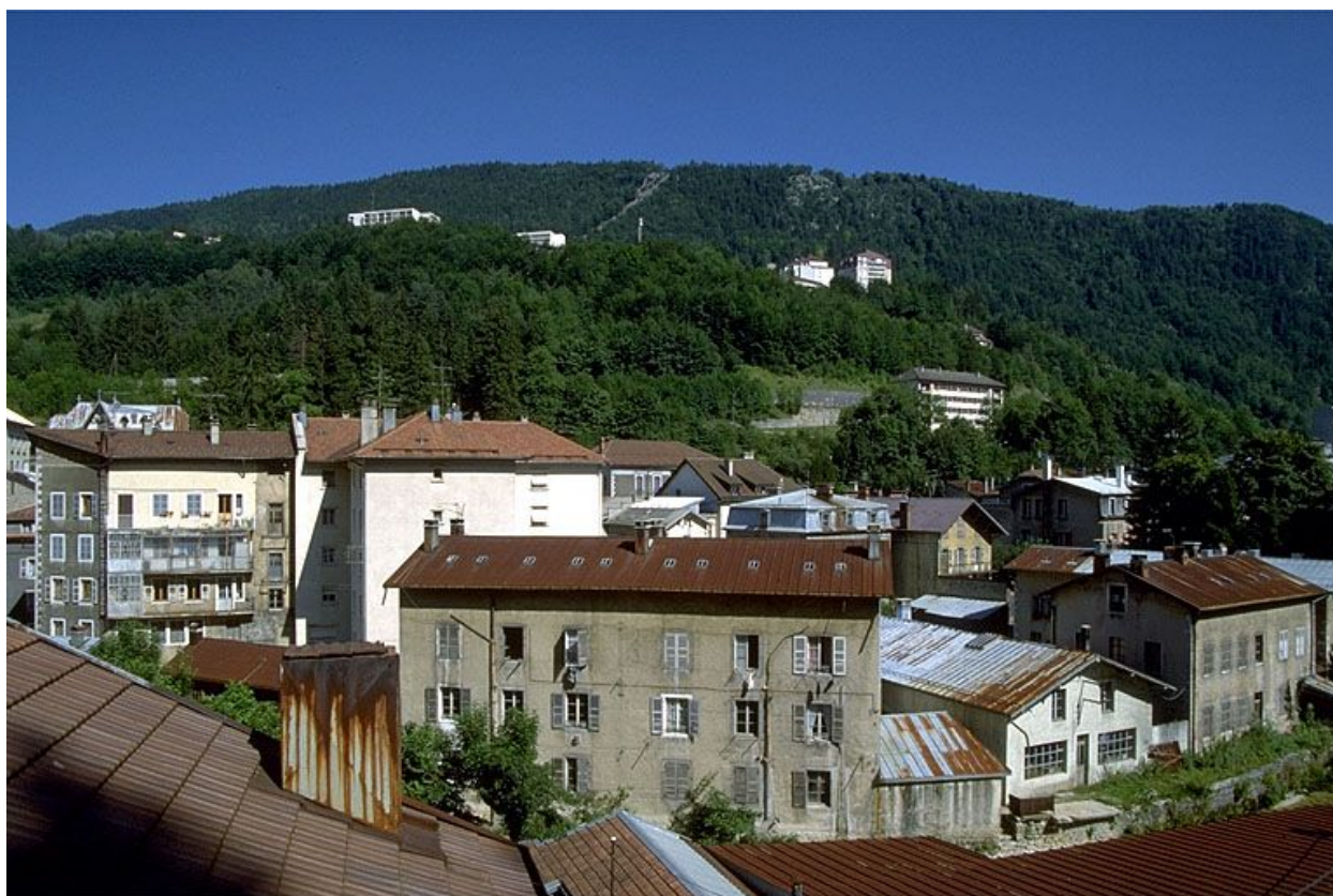
Vue d'ensemble depuis l'ouest.
