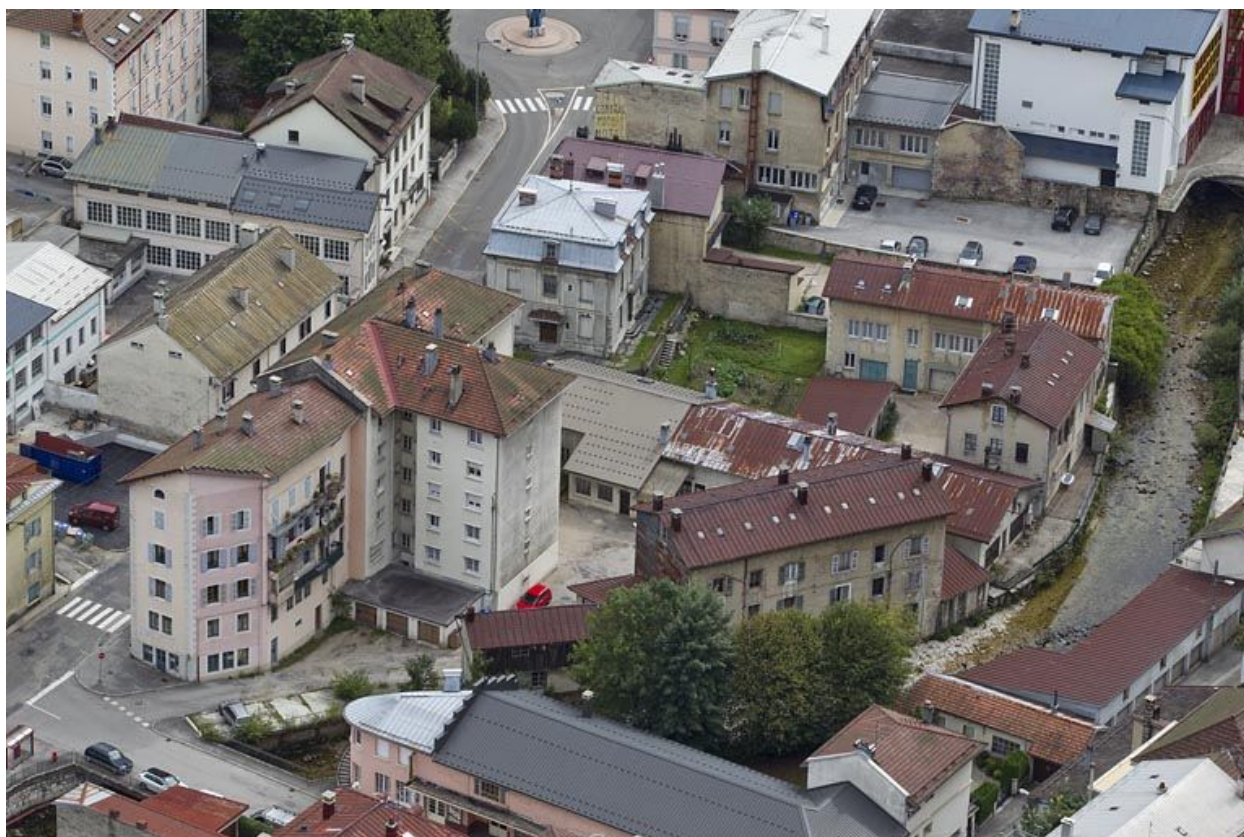
Vue d'ensemble plongeante, depuis le nord.
