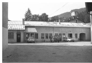
Atelier de fabrication dans la cour. Phot. Laurent Poupard IVR43_19913901542Z
