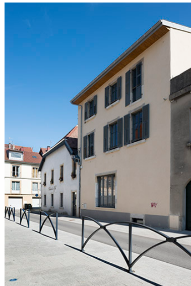
Façade sur la rue des Jardins. Phot. Jérôme Mongreville IVR43_20172500308NUC4A
