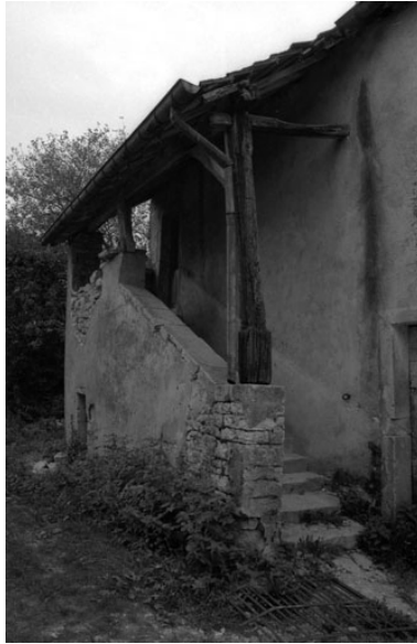
Détail de l'escalier. Phot. Bernard Lardière IVR43_19797000031Z
