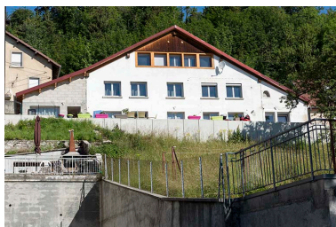
Façade est, vue en contre-plongée. Phot. Sonia Dourlot IVR43_20182500915NUC4A
