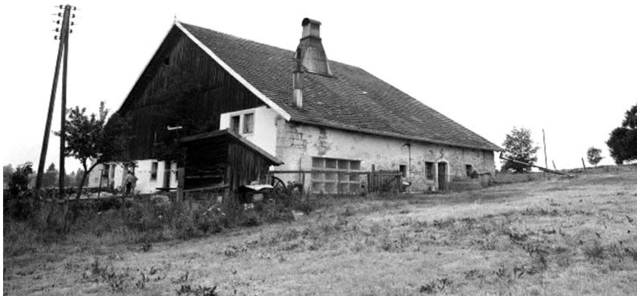
Façade antérieure et latérale droite.
