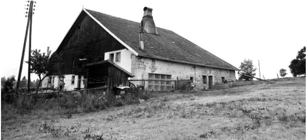
Façade antérieure et latérale droite.
