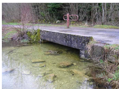
Vue générale sur l'ouvrage. Phot. Anne-Laure Madinier IVR43_20083900604NUC1A
