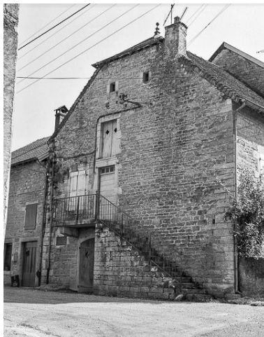
Façade latérale gauche. Phot. Yves Sancey IVR43_19843900282X
