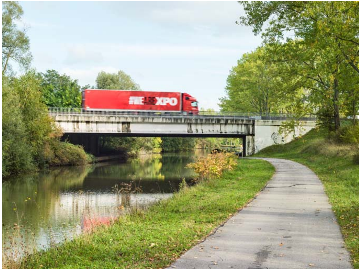
Vue d'ensemble du pont.
