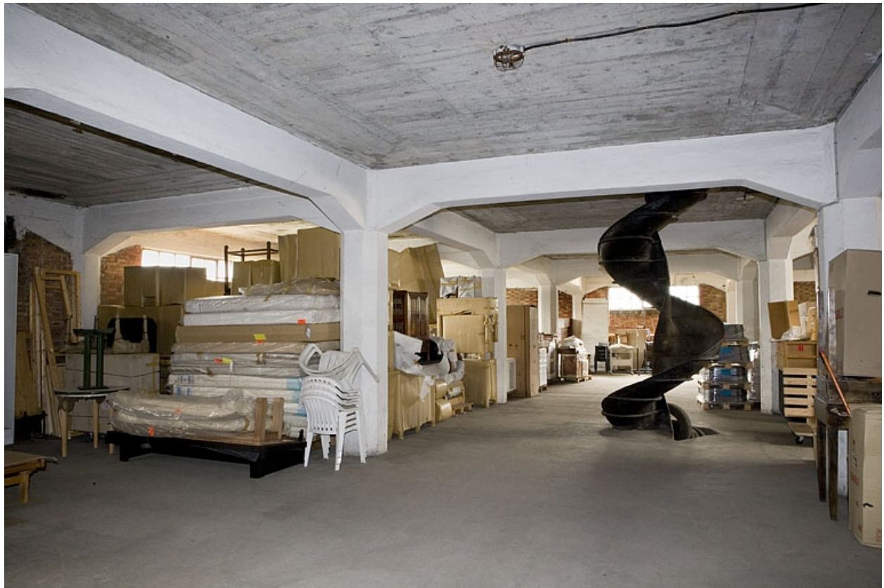
Entrepôt : intérieur du 2e étage.
