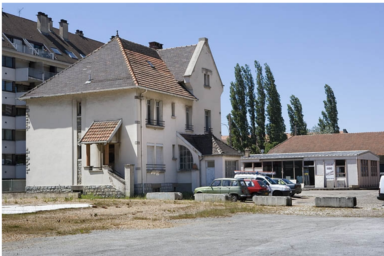
Bureau : façade postérieure de trois quarts gauche.
