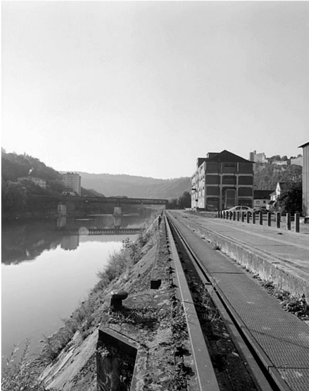
Entrepôt et quai, depuis l'aval.
