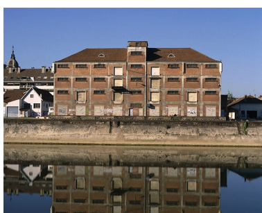
Entrepôt : façade postérieure (2003). Phot. Jérôme Mongreville IVR43_20032500175XA
