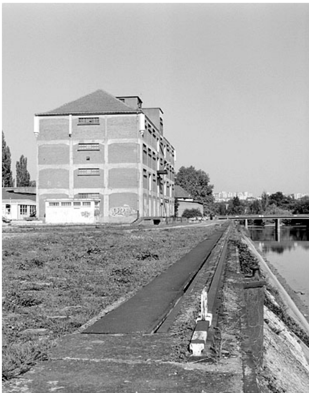
Entrepôt et quai, depuis l'amont (vue rapprochée)
