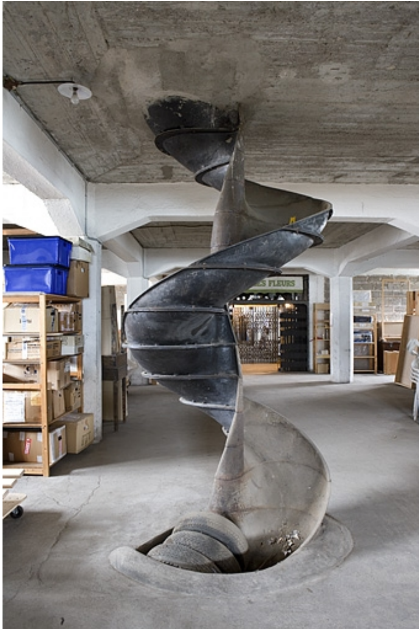
Entrepôt : toboggan à l'intérieur du 2e étage.
