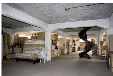
Entrepôt : intérieur du 2e étage. Phot. Yves Sancey IVR43_20062500265NUCA
