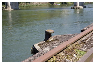
Bitte d'amarrage. Phot. Yves Sancey IVR43_20062500192NUCA
