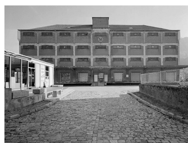
Entrepôt : façade antérieure. Phot. Jérôme Mongreville IVR43_20032500188V
