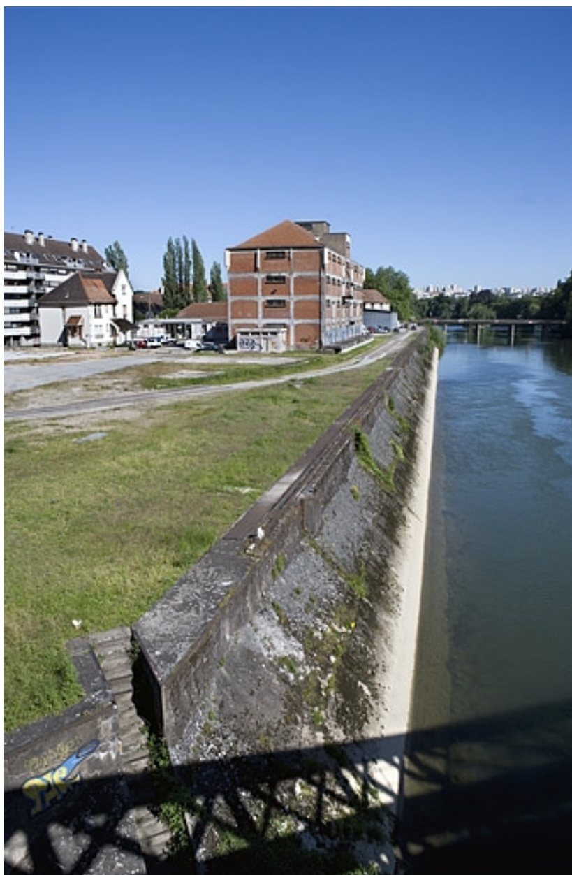
Entrepôt et quai, depuis l'amont.
