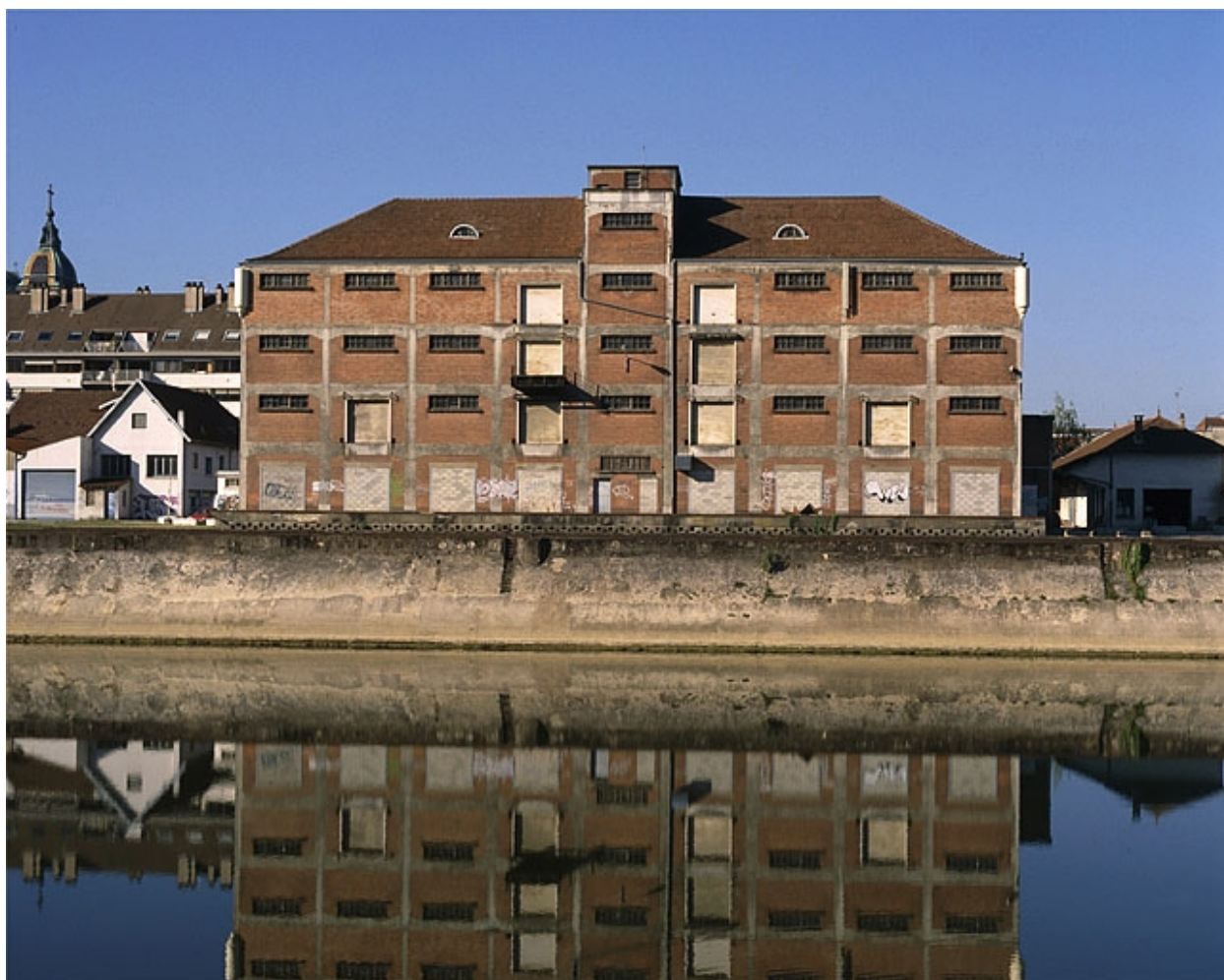
Entrepôt : façade postérieure (2003).
