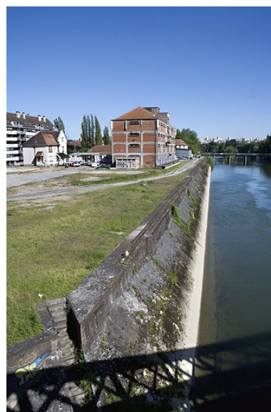
Entrepôt et quai, depuis l'amont. Phot. Yves Sancey IVR43_20062500163NUCA
