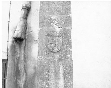
Extérieur : contrefort du chevet (blason). Phot. Yves Sancey IVR43_19753900827X
