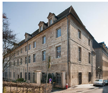
Façades des bâtiments d'externat sur la rue Bauzonnet avec portail donnant accès à la chapelle. Phot. Jérôme Mongreville IVR43_20143900242NUC4A
