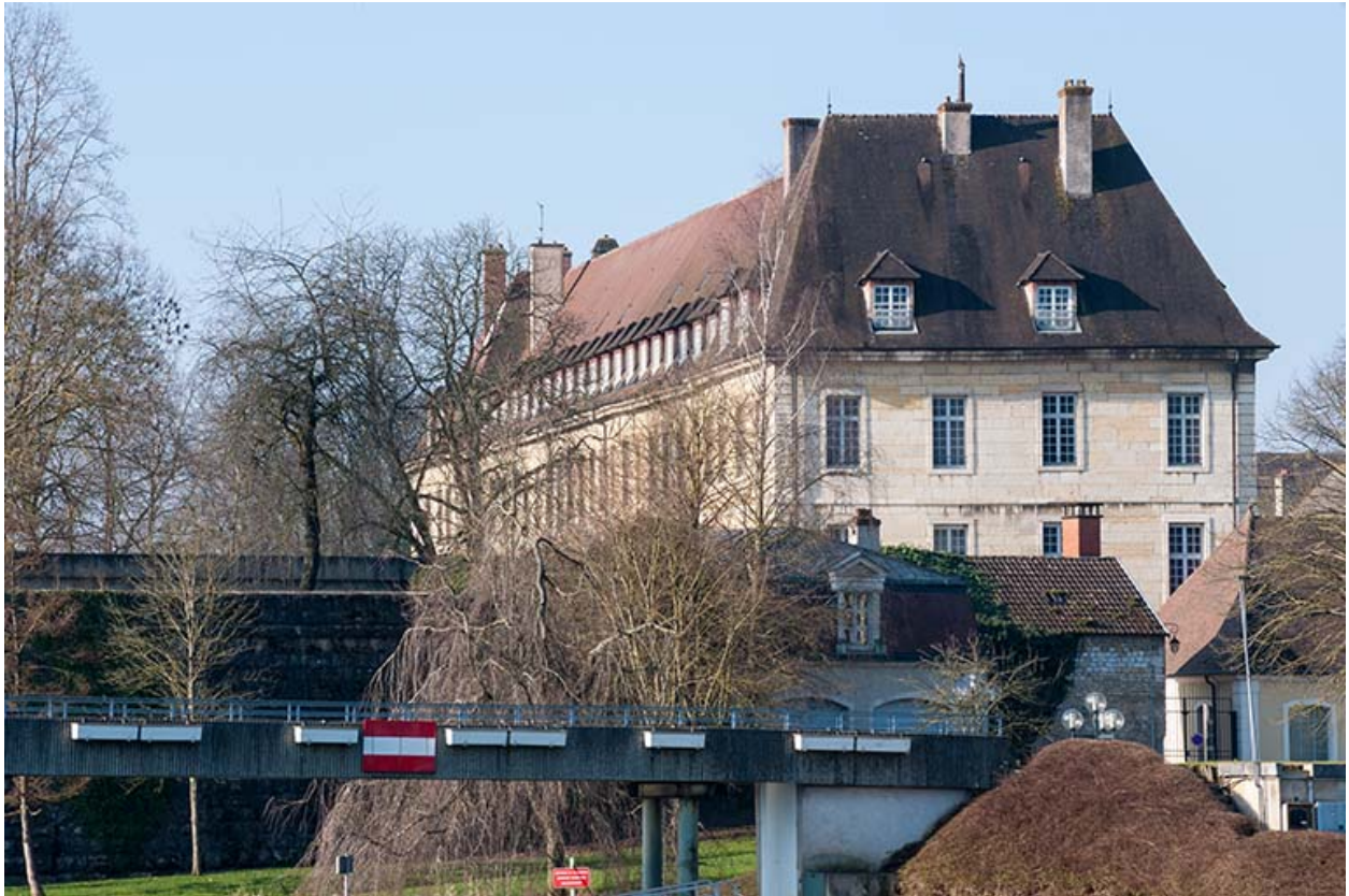
Ancien hôpital de la Charité, actuellement internat, détail des toitures.
