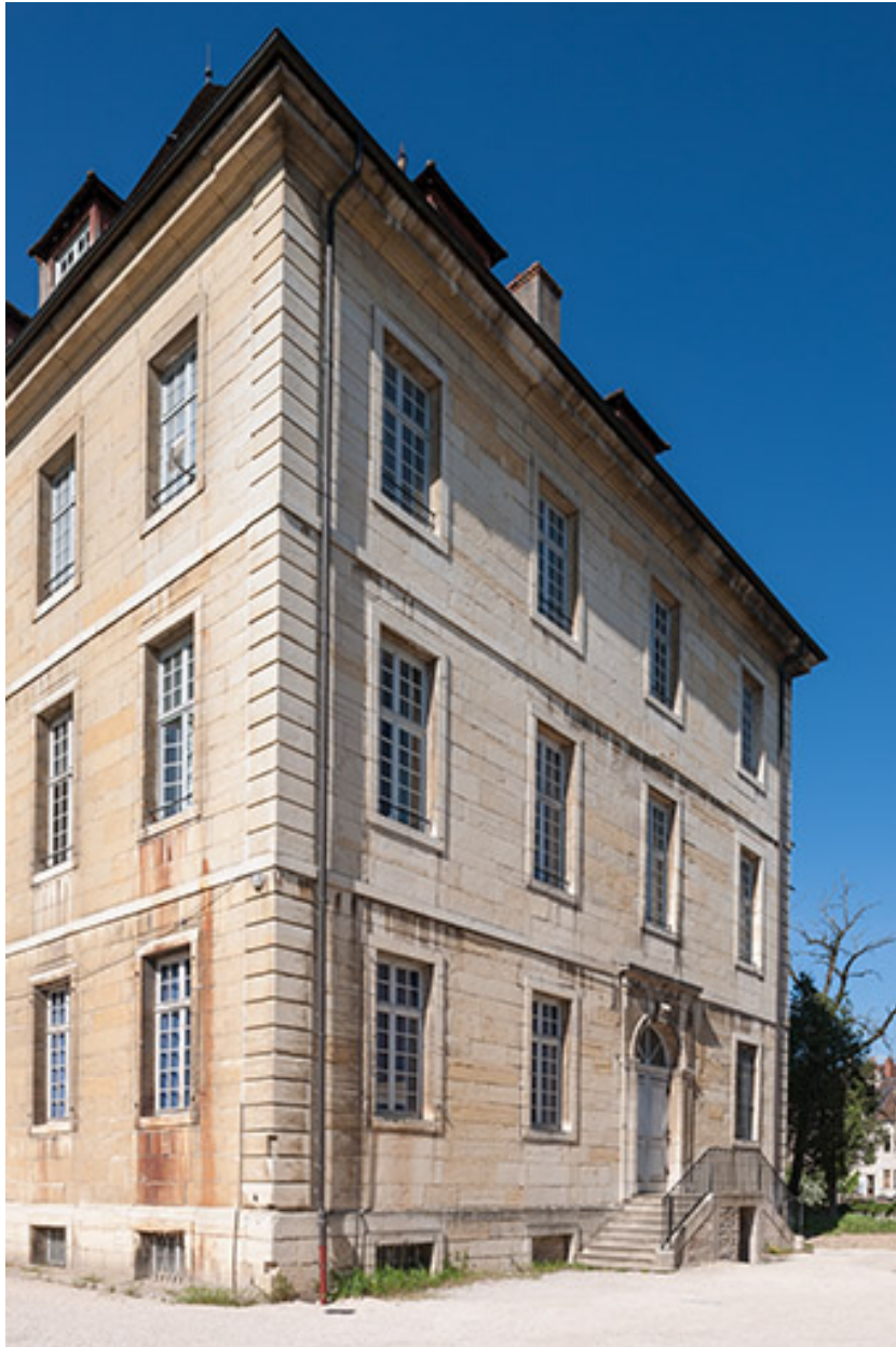
Ancien hôpital de la Charité, actuellement internat, pignon Est.
