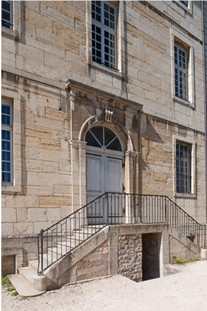
Portail de l'internat, pignon Est.
