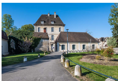
Hôpital de la Charité, actuellement internat, entrée Est avec bâtiments transformés en salles de sports. Phot. Jérôme Mongreville IVR43_20143900250NUC4A
