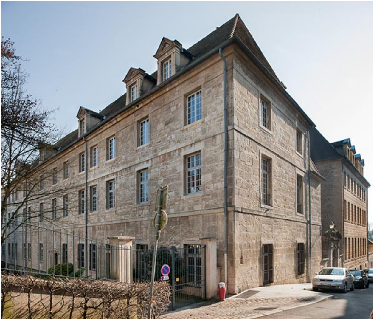
Façades des bâtiments d'externat sur la rue Bauzonnet avec portail donnant accès à la chapelle.
