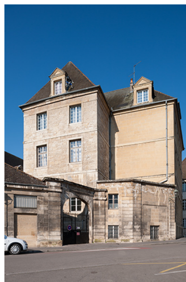
Externat : entrée, rue des Boucheries. Phot. Jérôme Mongreville IVR43_20143900219NUC4A
