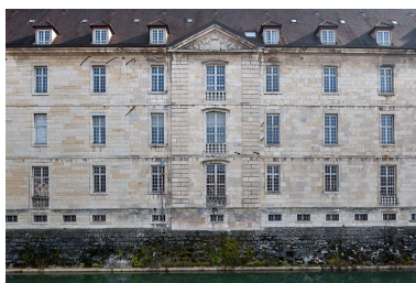
Ancien Hôpital de la Charité, vue de la façade antérieure sur le canal des Tanneurs. Phot. Jérôme Mongreville IVR43_20143900248NUC4A
