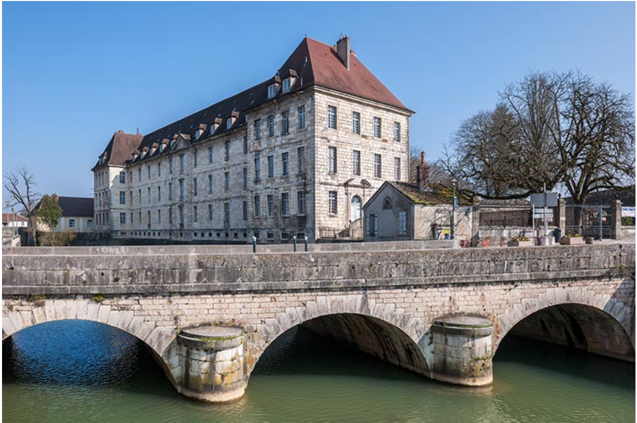
Ancien hôpital de la Charité, actuellement internat, vue générale.
