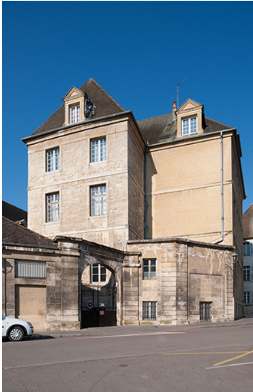
Externat : entrée, rue des Boucheries.
