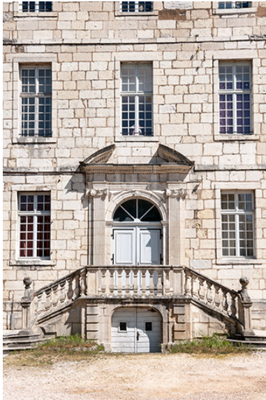
Ancien hôpital de la Charité, actuellement internat, portail d'entrée ouest. Phot. Jérôme Mongreville IVR43_20143900258NUC4A
