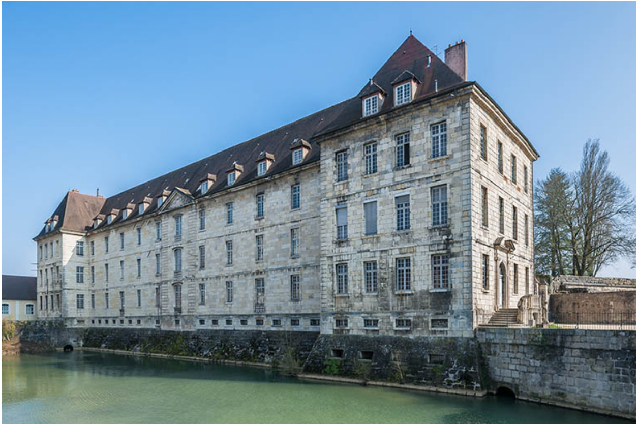
Ancien hôpital de la Charité, façade antérieure.
