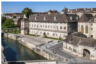
Vue du site externat depuis la rue Bauzonnet. Phot. Jérôme Mongreville IVR43_20143900227NUC4A
