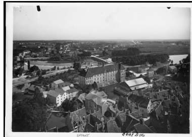
Vue de situation [1re moitié 20e siècle]. Autr. Jules Manias IVR43_20063900454PY
