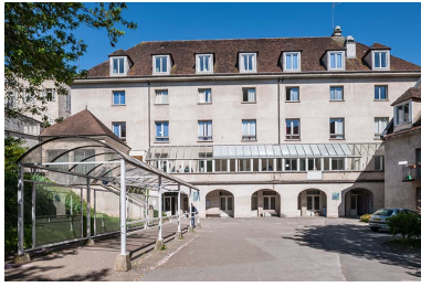
Bâtiment restauration scolaire, vue générale. Phot. Jérôme Mongreville IVR43_20143900232NUC4A
