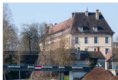
Ancien hôpital de la Charité, actuellement internat, détail des toitures. Phot. Jérôme Mongreville IVR43_20143900244NUC4A
