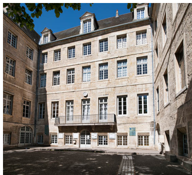
Façades de l'externat sur la cour intérieure. Phot. Jérôme Mongreville IVR43_20143900243NUC4A
