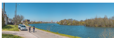
L'amont du quai avec en arrière-plan, le viaduc des Dombes. À droite, les îles de Benne-la-Faux dans la Saône. Phot. Thierry Kuntz IVR26_20217100088NUC4A
