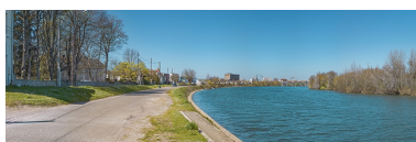
Les perrés du quai, avec en arrière- plan, le viaduc des Dombes. Phot. Thierry Kuntz IVR26_20217100089NUC4A
