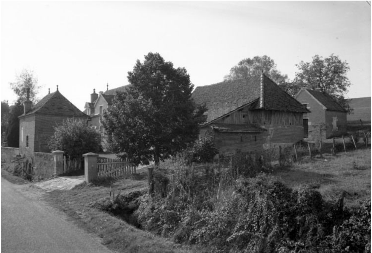
Vue d'ensemble prise du nord-est.
