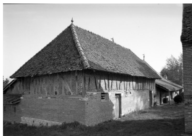
Dépendances, élévations latérale et postérieure. Phot. Michel Rosso IVR26_19852101114V
