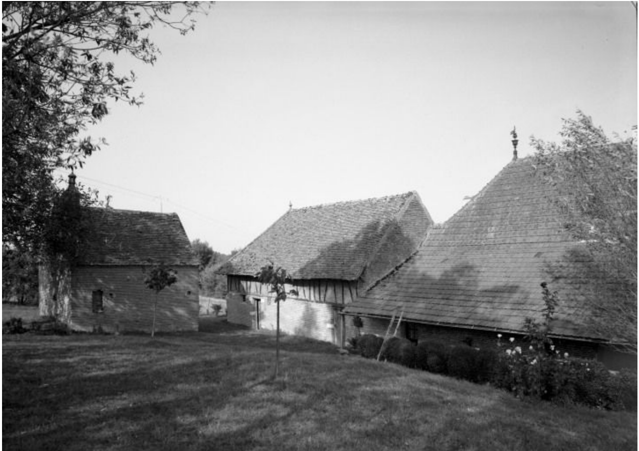
Vue d'ensemble prise du sud-ouest.
