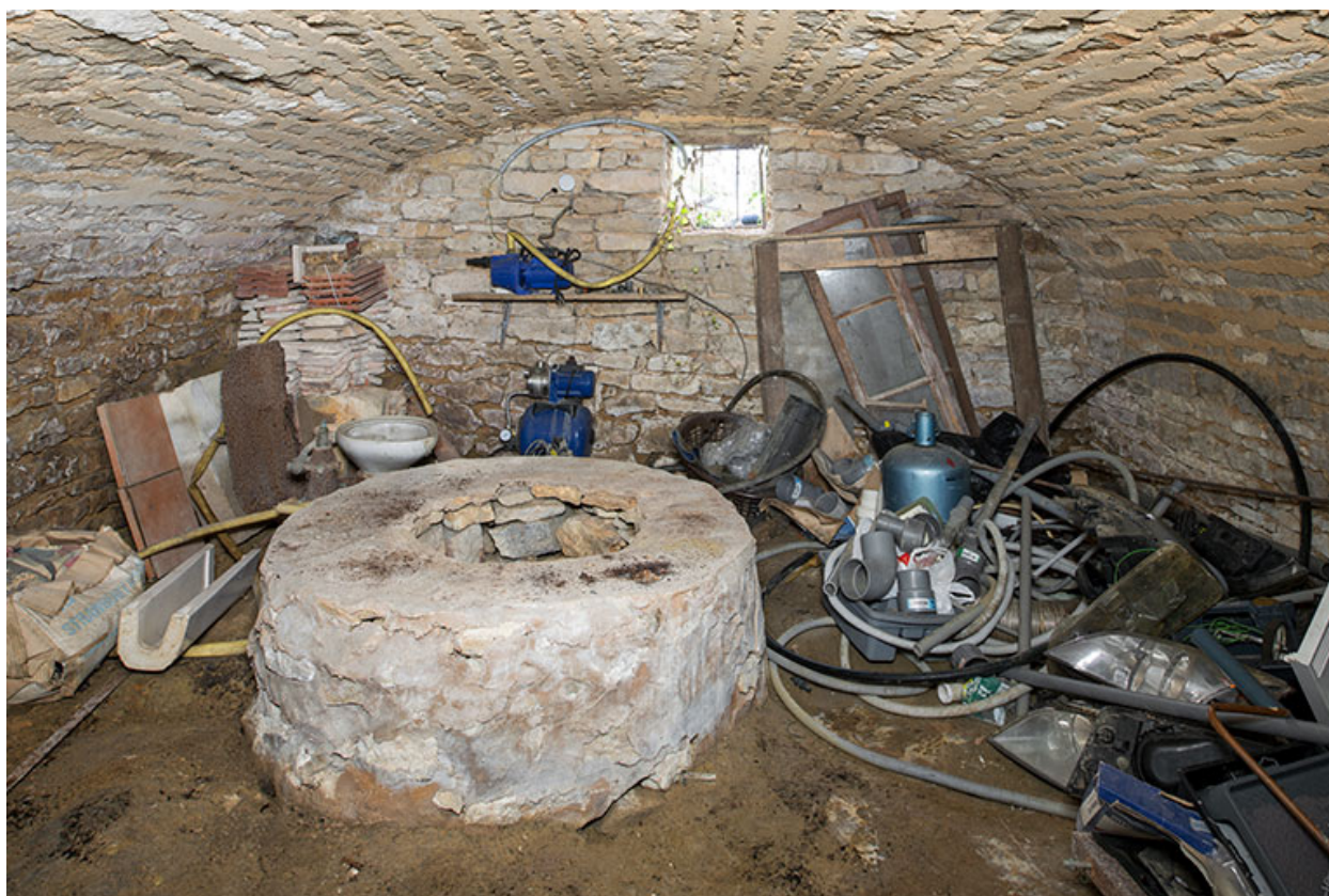
Le second cellier et son puits.
