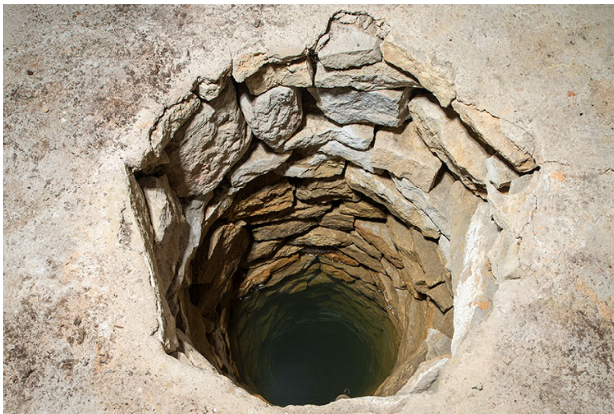
L'intérieur du puits.
