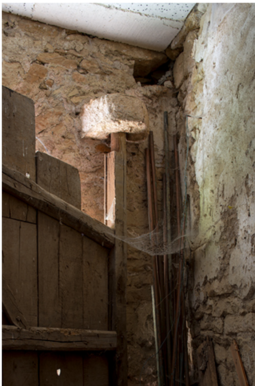
Détail du fonctionnement de la porte charretière : poteau-tourillon et crapaudine.
