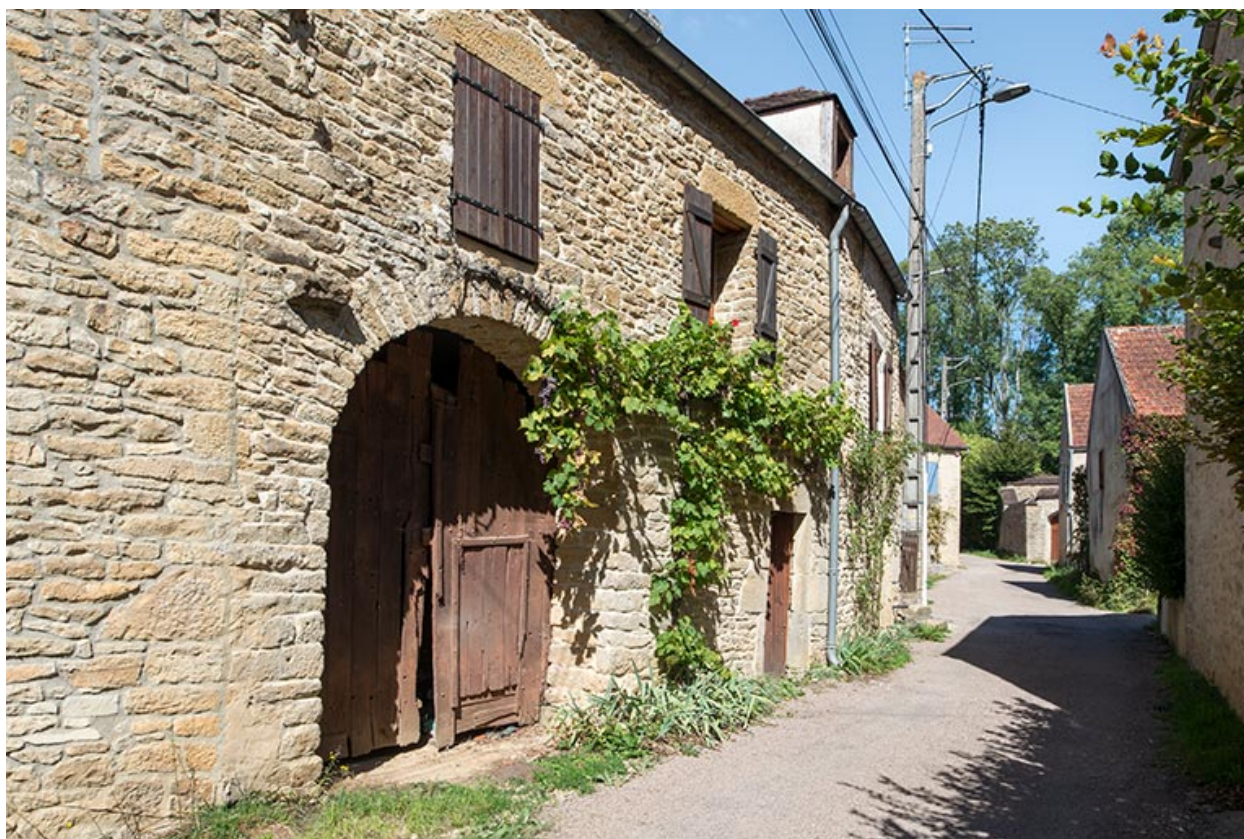
La ferme depuis l'ouest.
