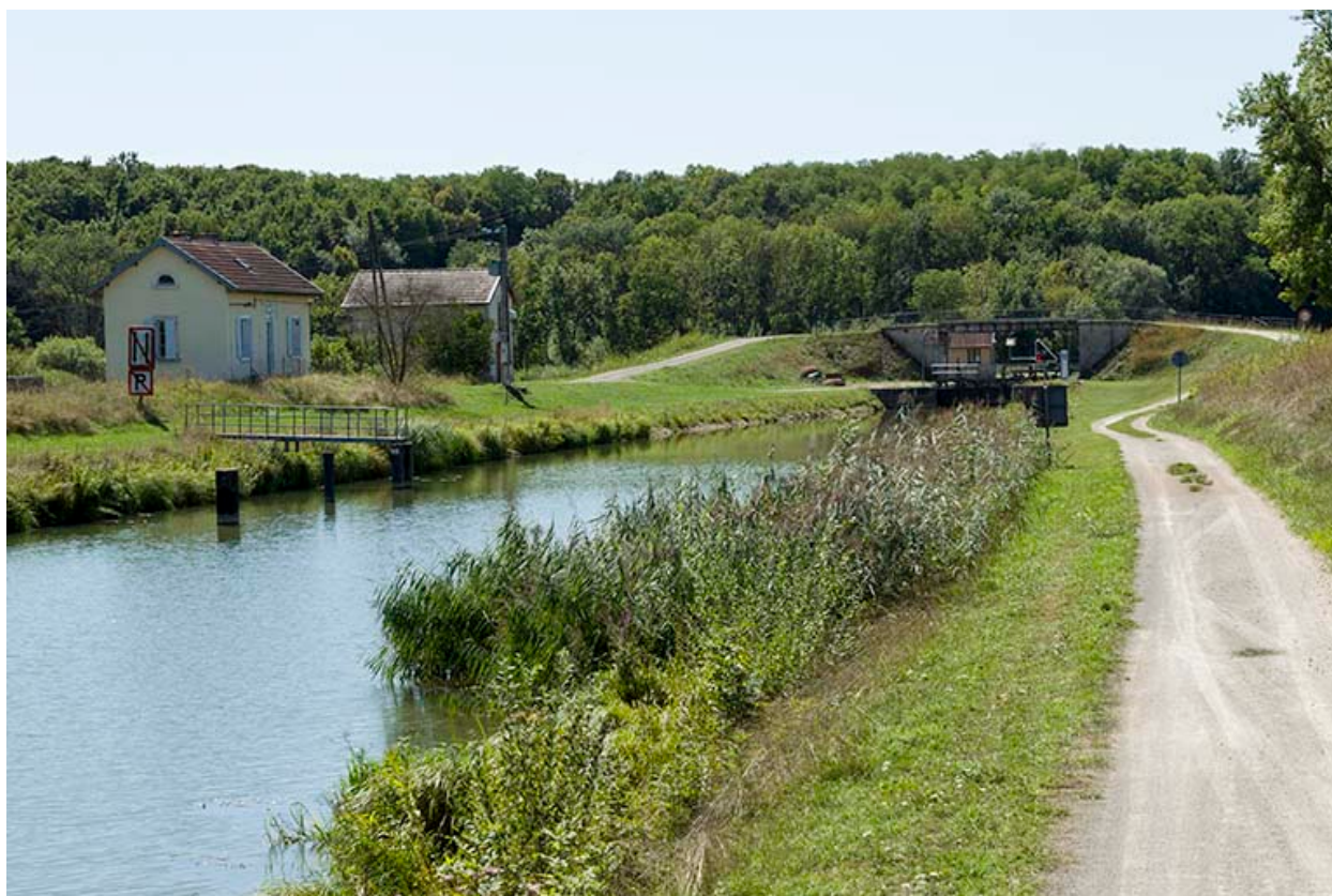
Vue générale du site d'écluse.
