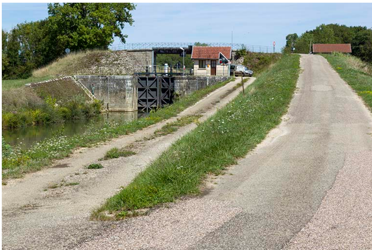
Vue du site d'écluse depuis l'aval.
