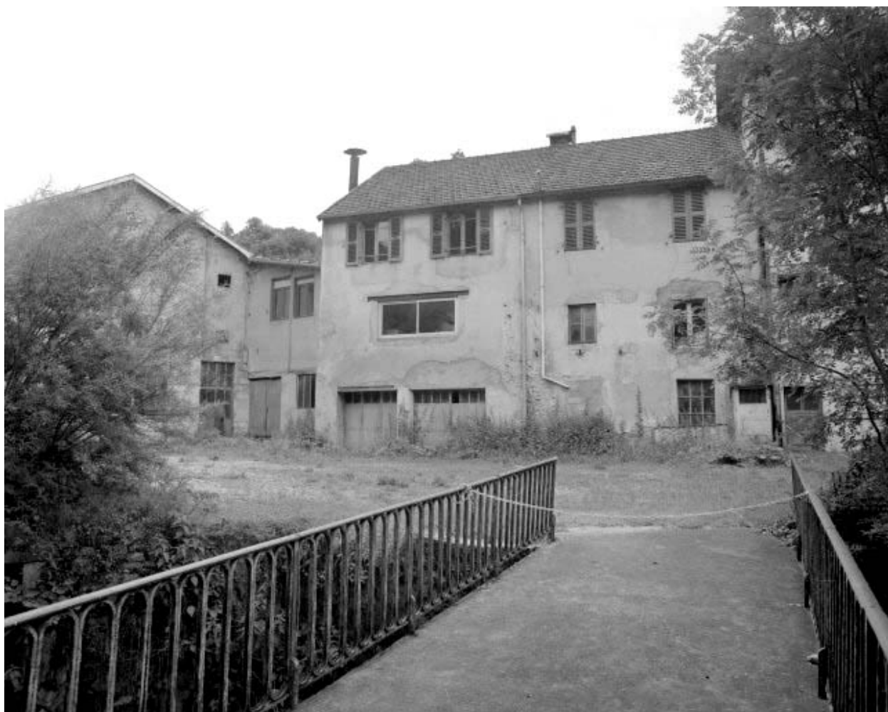
Façade postérieure du bureau et du logement.
