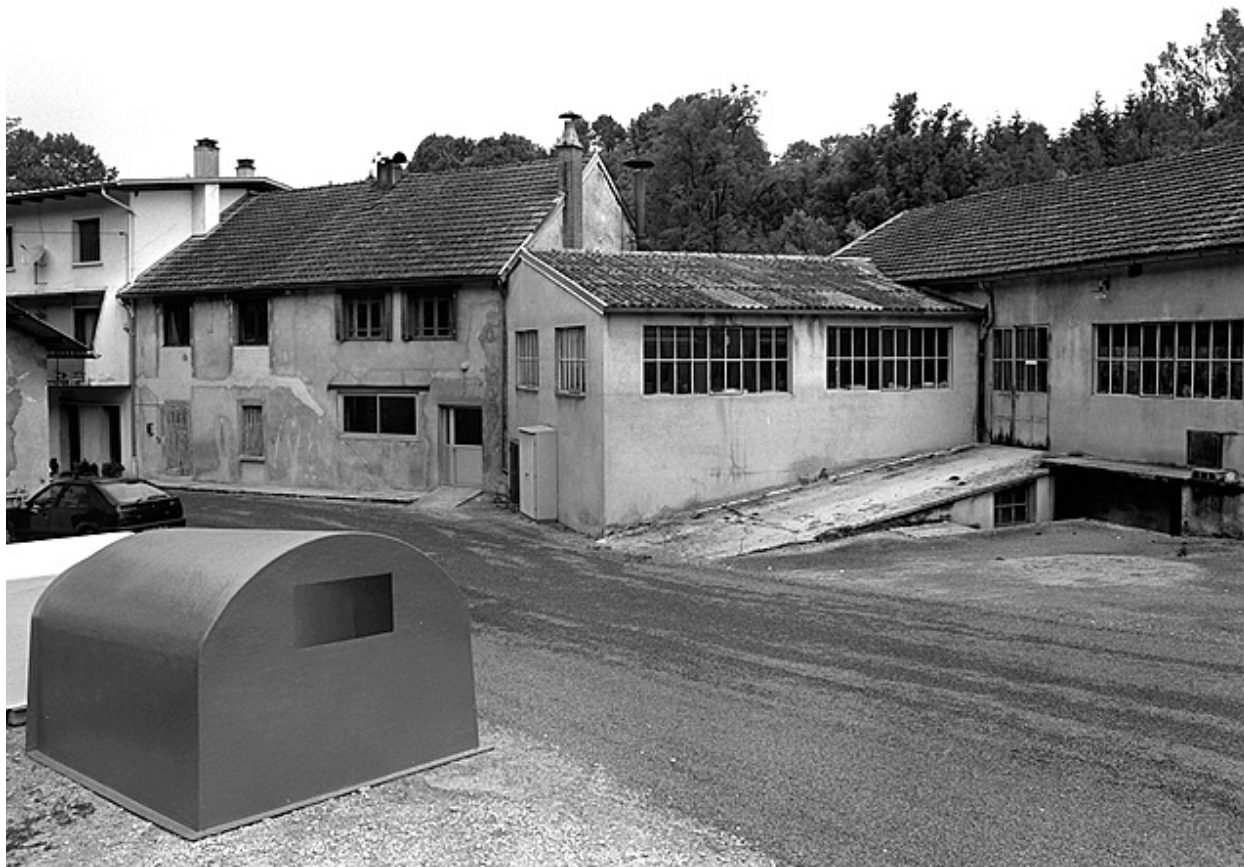
Bureau et atelier de fabrication.
