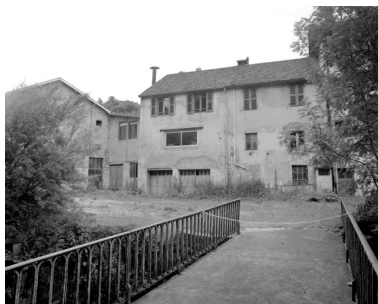
Façade postérieure du bureau et du logement. Phot. Jérôme Mongreville IVR43_19963900581X
