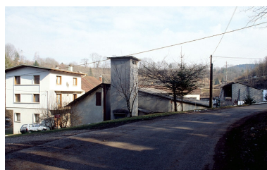
Logement patronal et magasin industriel. Phot. Jérôme Mongreville IVR43_19963900142ZA
