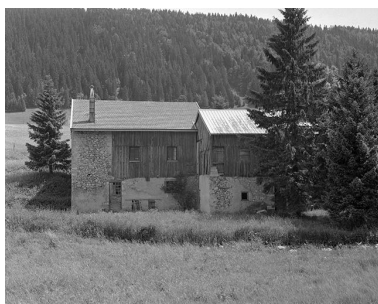
Façade le long de l'Orbe. Phot. Jérôme Mongreville IVR43_20003900265X
