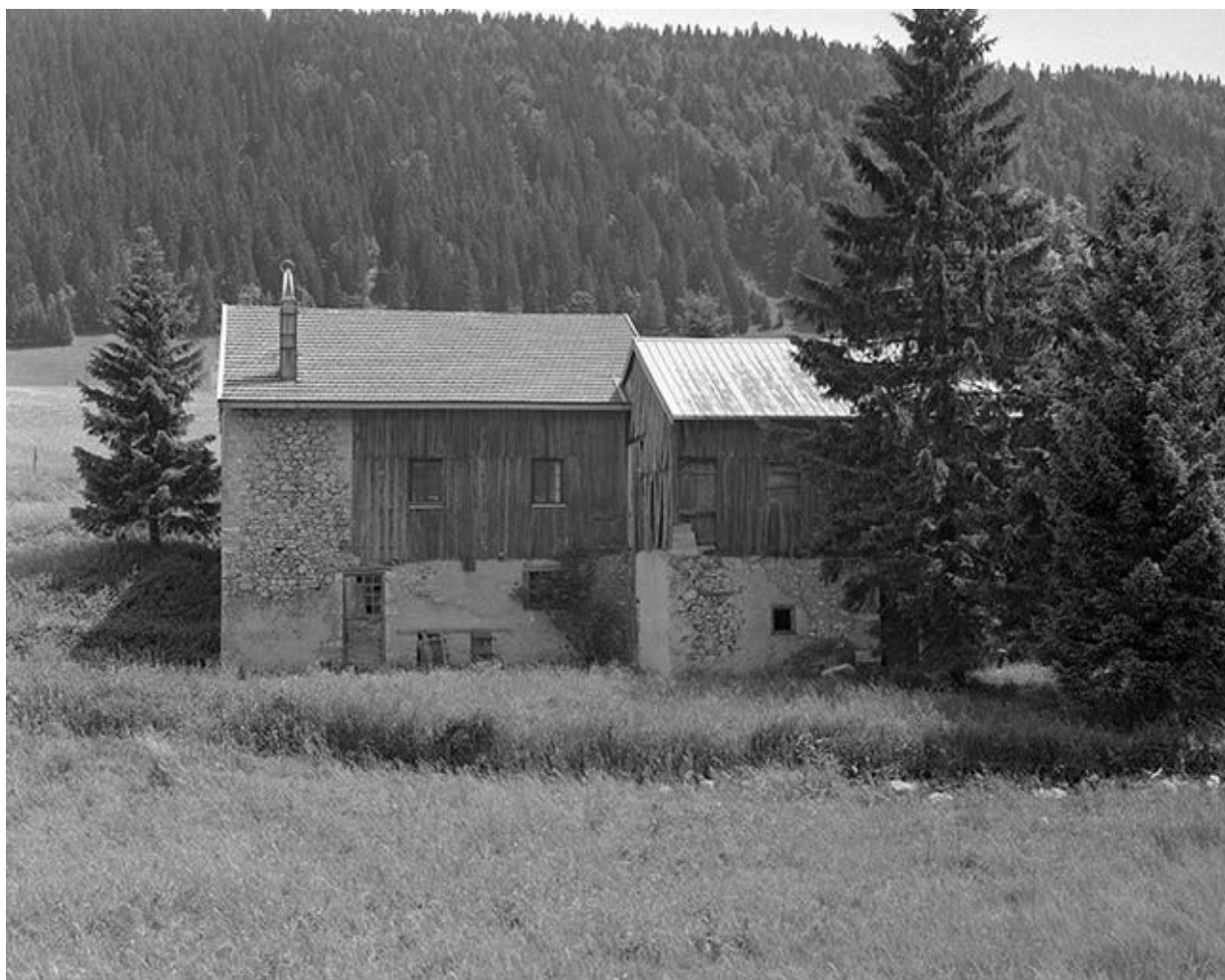
Façade le long de l'Orbe.
