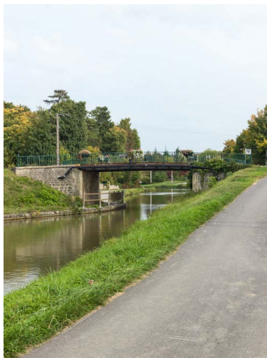
Vue d'ensemble du pont.
