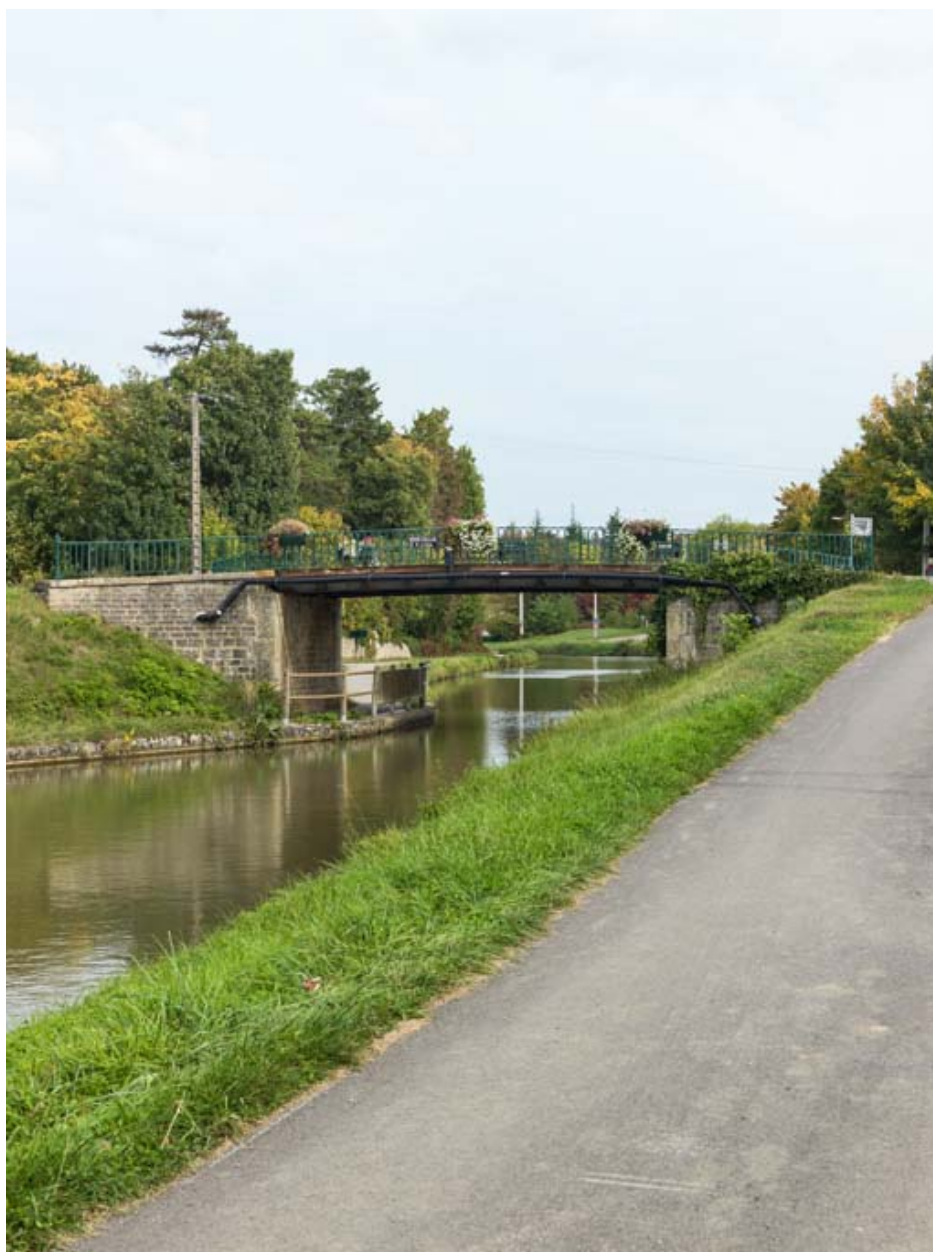
Vue d'ensemble du pont.
