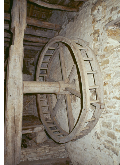
La roue à écureuil. Phot. Jean-Luc Duthu IVR26_20028900404ZA
