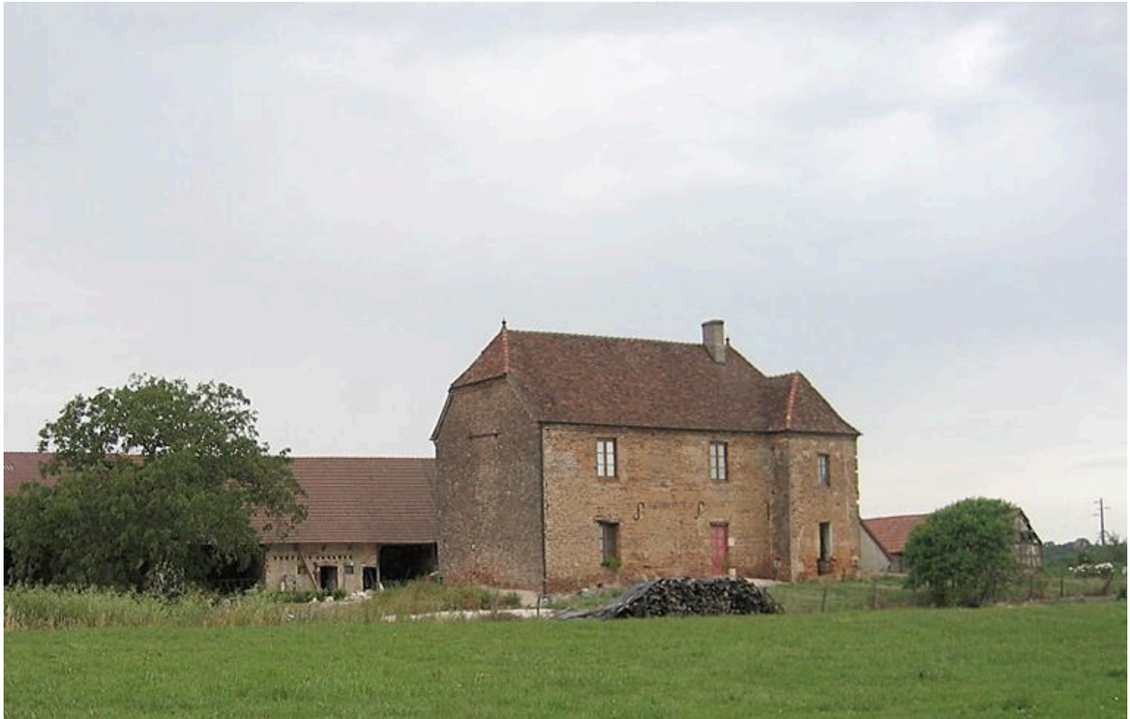
Vue d'ensemble de la façade.
