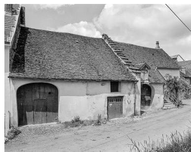
Ferme située rue Chateraine : façade antérieure.
