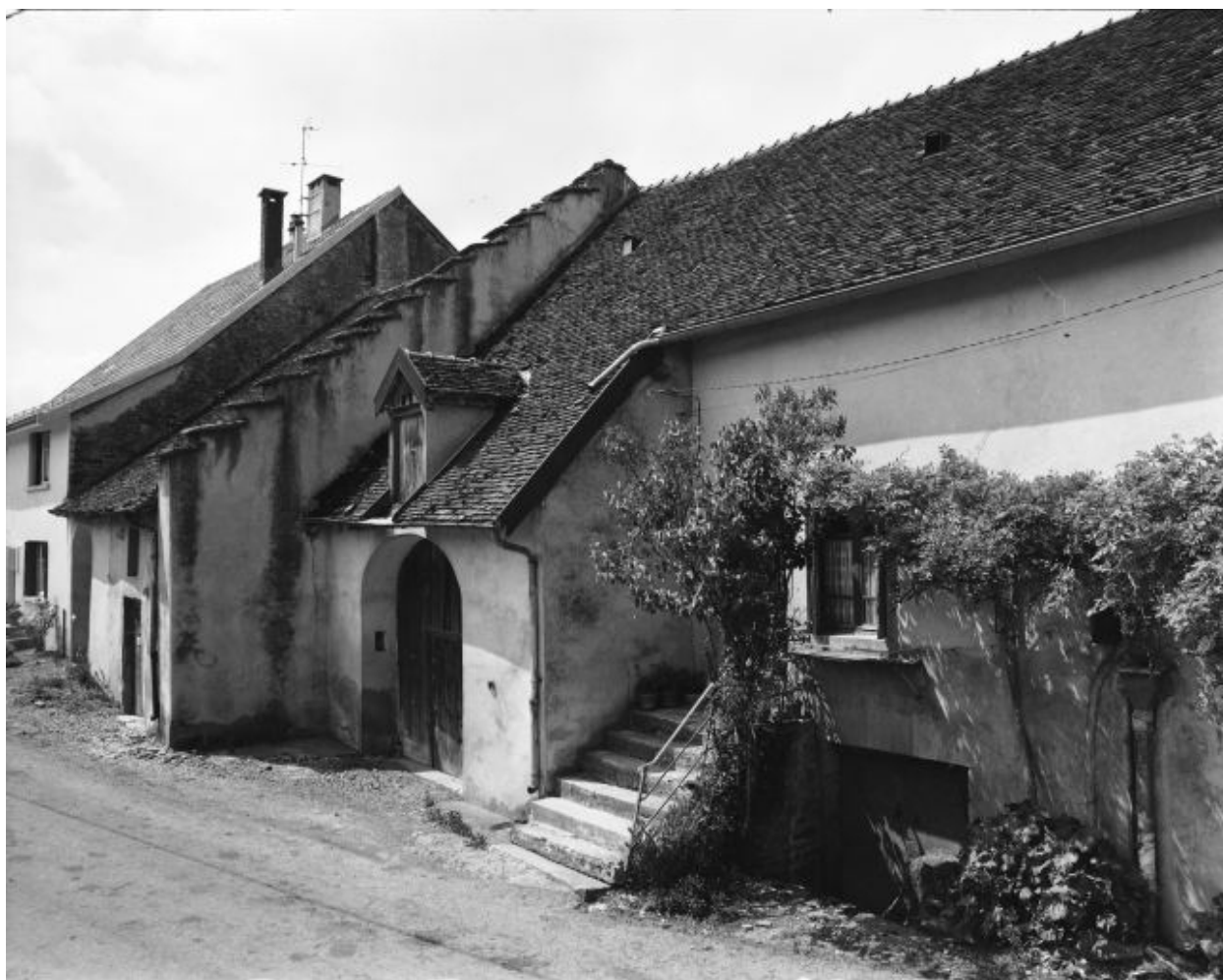
Ferme située rue Chateraine : façade antérieure.
