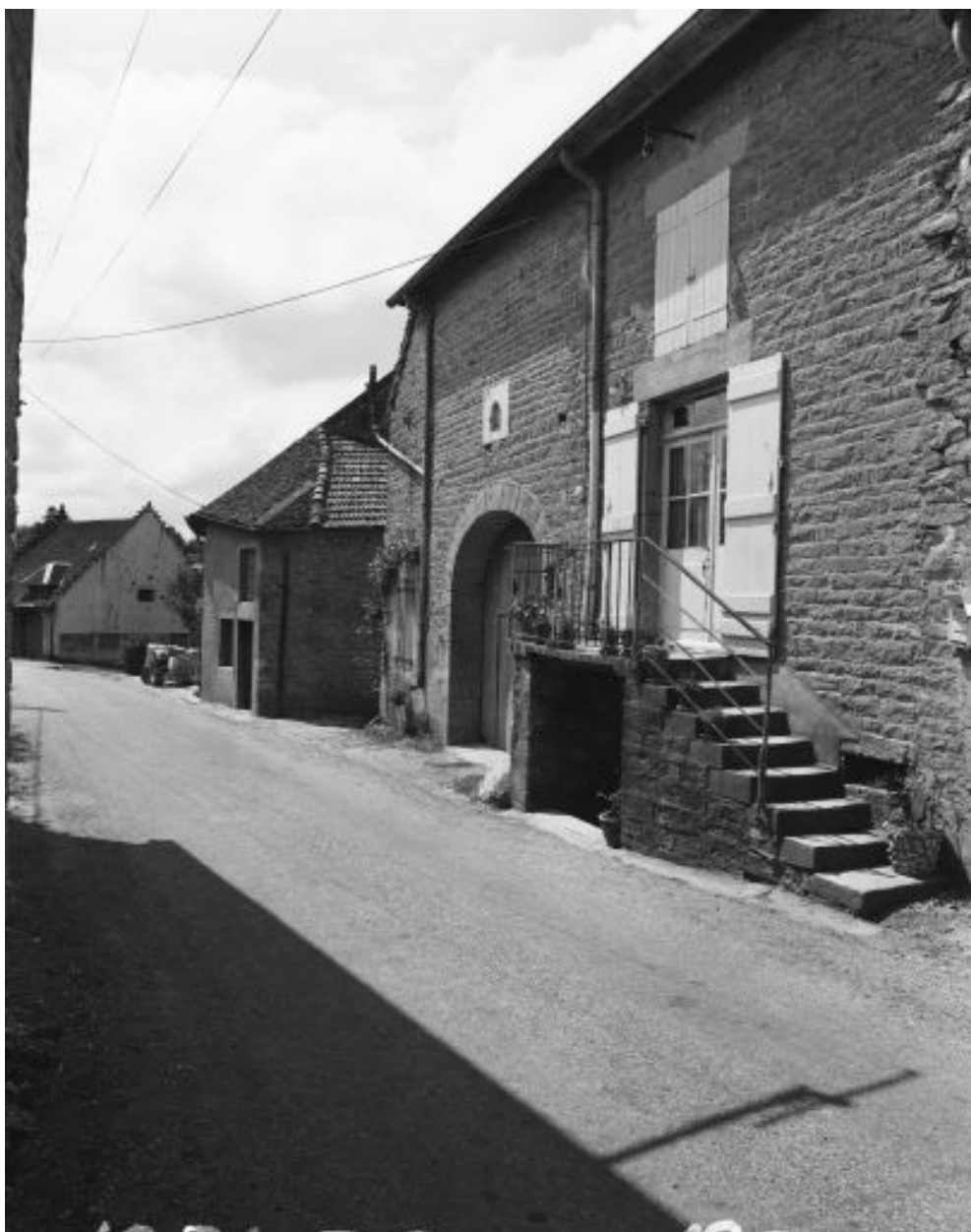
Ferme située rue Chateraine : façade antérieure.
