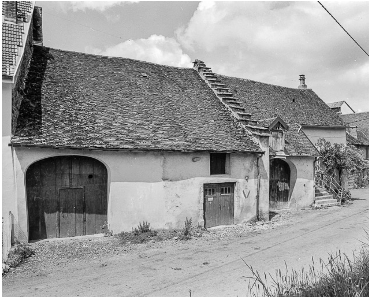
Ferme située rue Chateraine : façade antérieure.
