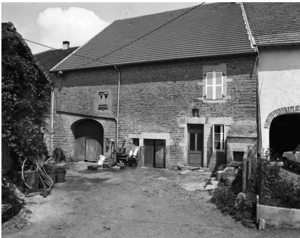
Ferme située chemin de la Massette : façade antérieure.
