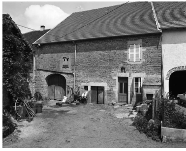
Ferme située chemin de la Massette : façade antérieure. Phot. Yves Sancey IVR43_19813900196X
