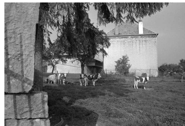
Façade latérale gauche des parties agricoles. Phot. Gilbert Poinot IVR43_19762500928Z
