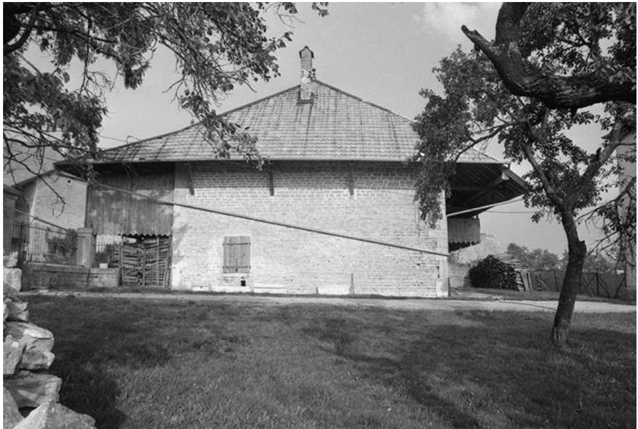
Façade latérale droite des parties agricoles.
