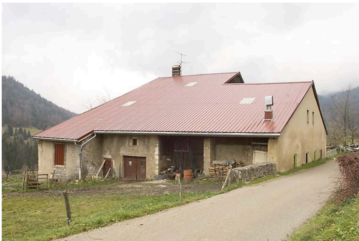
Façades nord et ouest.
