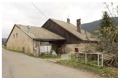
Façades sud et ouest. Phot. Jérôme Mongreville IVR43_20082501056NUC2A
