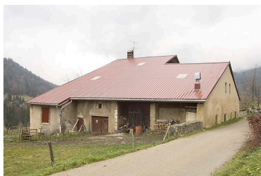
Façades nord et ouest. Phot. Jérôme Mongreville IVR43_20082501055NUC2A
