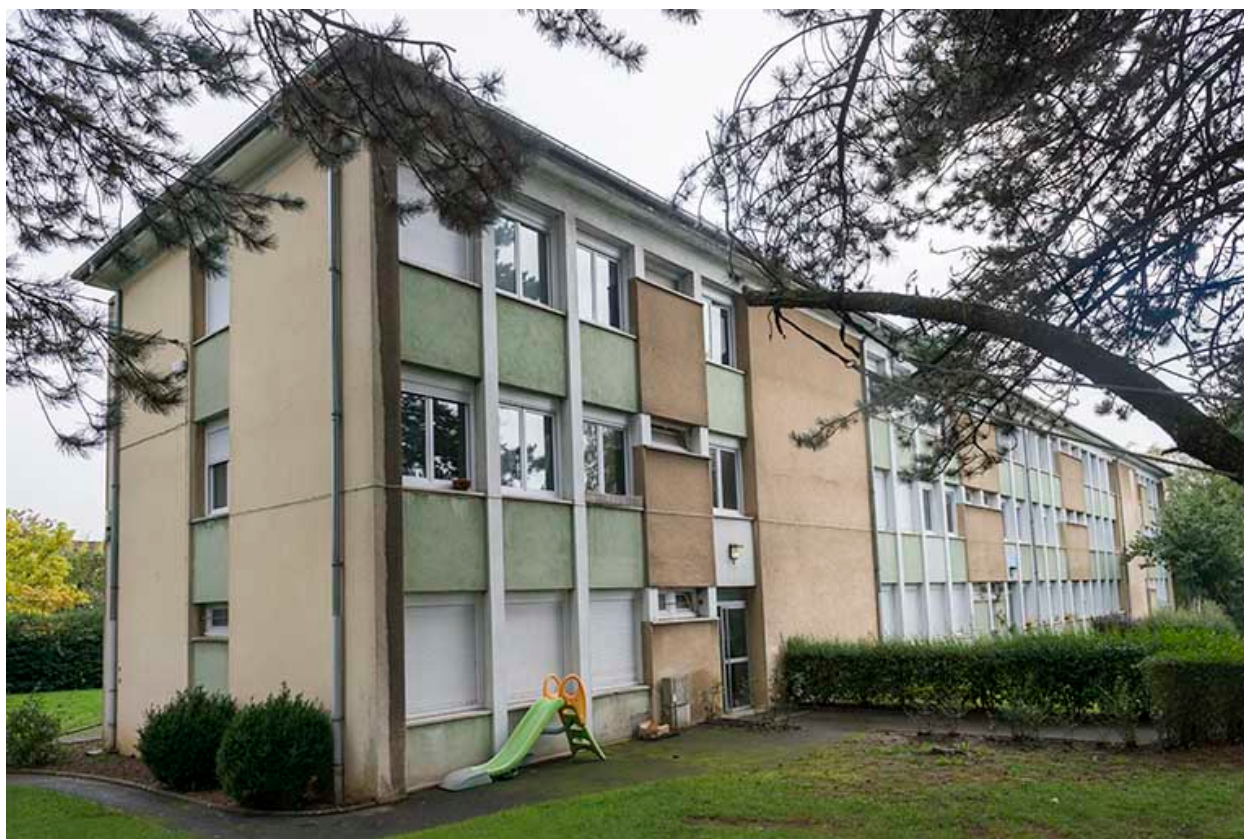
Façade est de la barre de logements.
