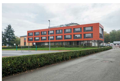
Façade ouest est et angle sud- ouest du pôle scientifique. Phot. Mary Ruffinoni IVR43_20139000036NUC4A
