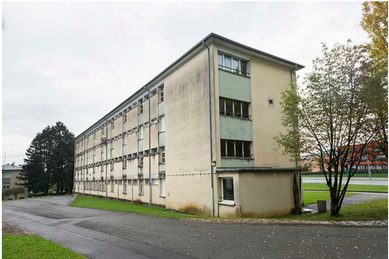
Angle sud-ouest de l'internat de garçons ouest.
