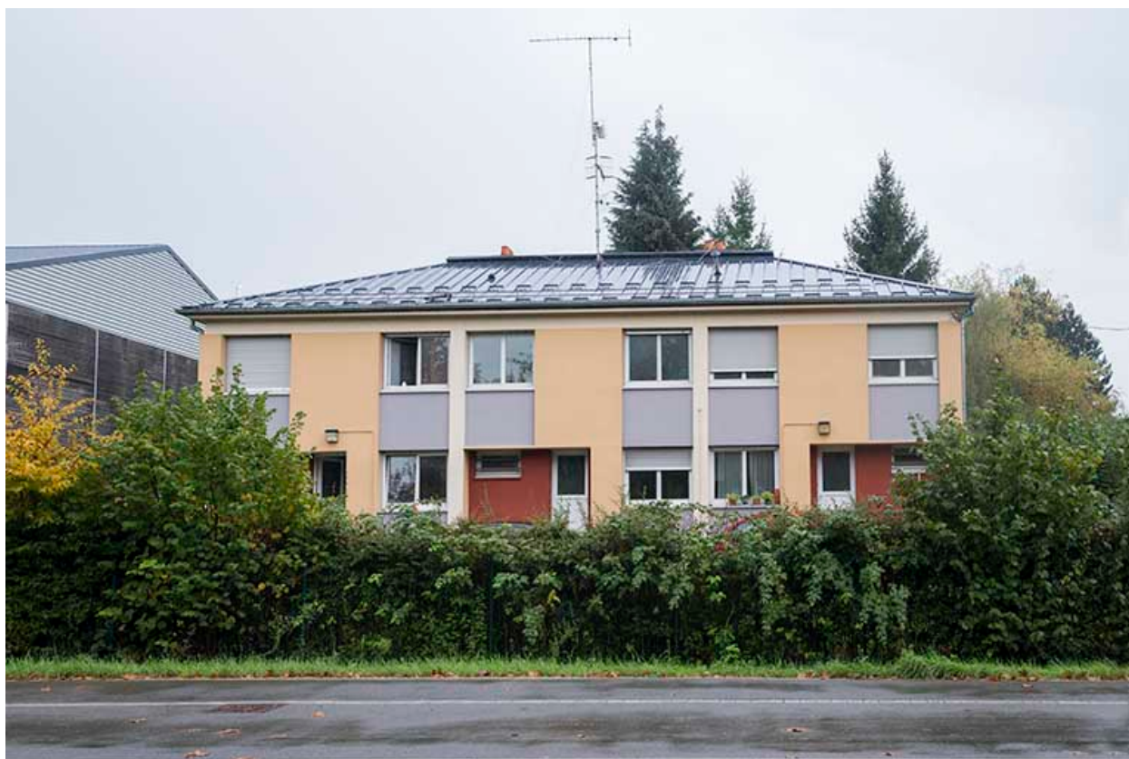
Façade nord du bloc des logements nord.
