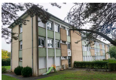
Façade est de la barre de logements. Phot. Mary Ruffinoni IVR43_20139000043NUC4A
