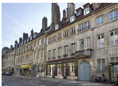
Vue d'ensemble de la façade sur rue, de trois quarts droit. Phot. Yves Sancey IVR43_20092501045NUC2A
