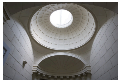
Couvrement de l'escalier : détail de la coupole et d'une demi-coupole. Phot. Yves Sancey IVR43_20092501058NUC2A
