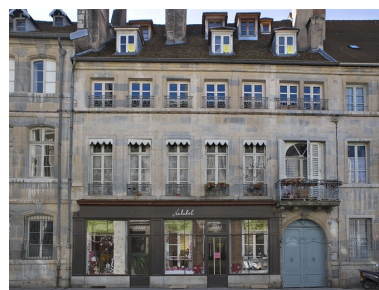
Vue d'ensemble de la façade sur rue, de face. Phot. Yves Sancey IVR43_20092501044NUC2A
