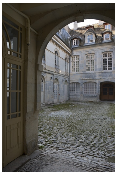
Vue des bâtiments sur cour depuis l'entrée du passage cocher. Phot. Yves Sancey IVR43_20092501052NUC2A
