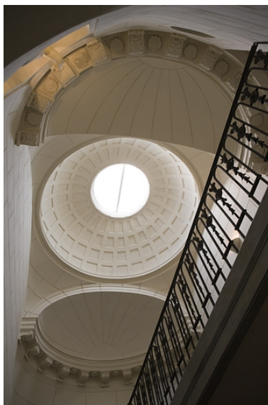
Couvrement de l'escalier : détail de la coupole et des deux demi-coupoles. Phot. Yves Sancey IVR43_20092501059NUC2A
