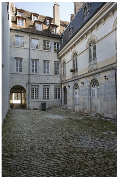
Façade postérieure du logis sur rue et l'aile sur cour. Phot. Yves Sancey IVR43_20092501054NUC2A
