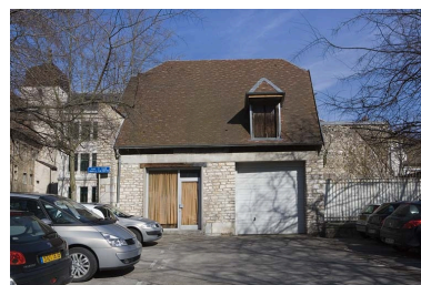
Bâtiment des remise et écurie depuis la place du Théâtre. Phot. Yves Sancey IVR43_20092501047NUC2A
