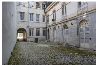
Façade postérieure du logis sur rue et aile sur cour : rez- de-chaussée et premier étage. Phot. Yves Sancey IVR43_20092501055NUC2A
