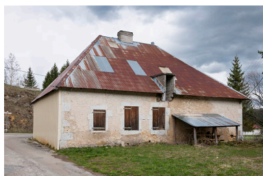
Façades postérieure et latérale droite en 2016.
