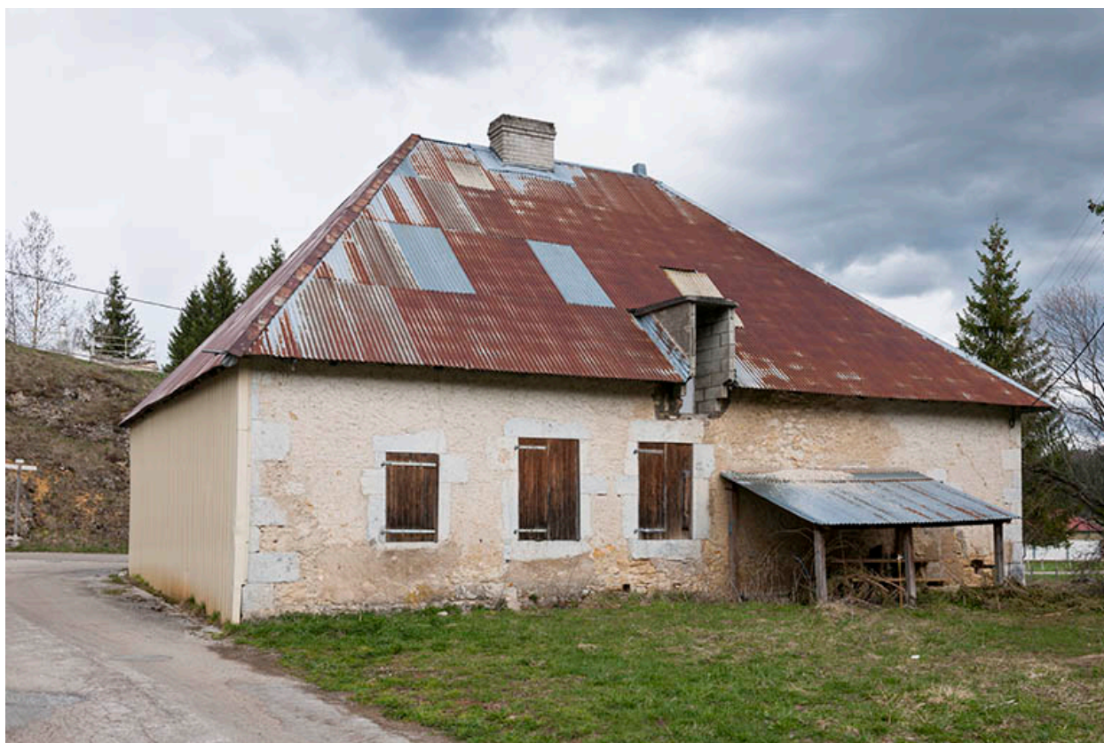
Façades postérieure et latérale droite en 2016.
