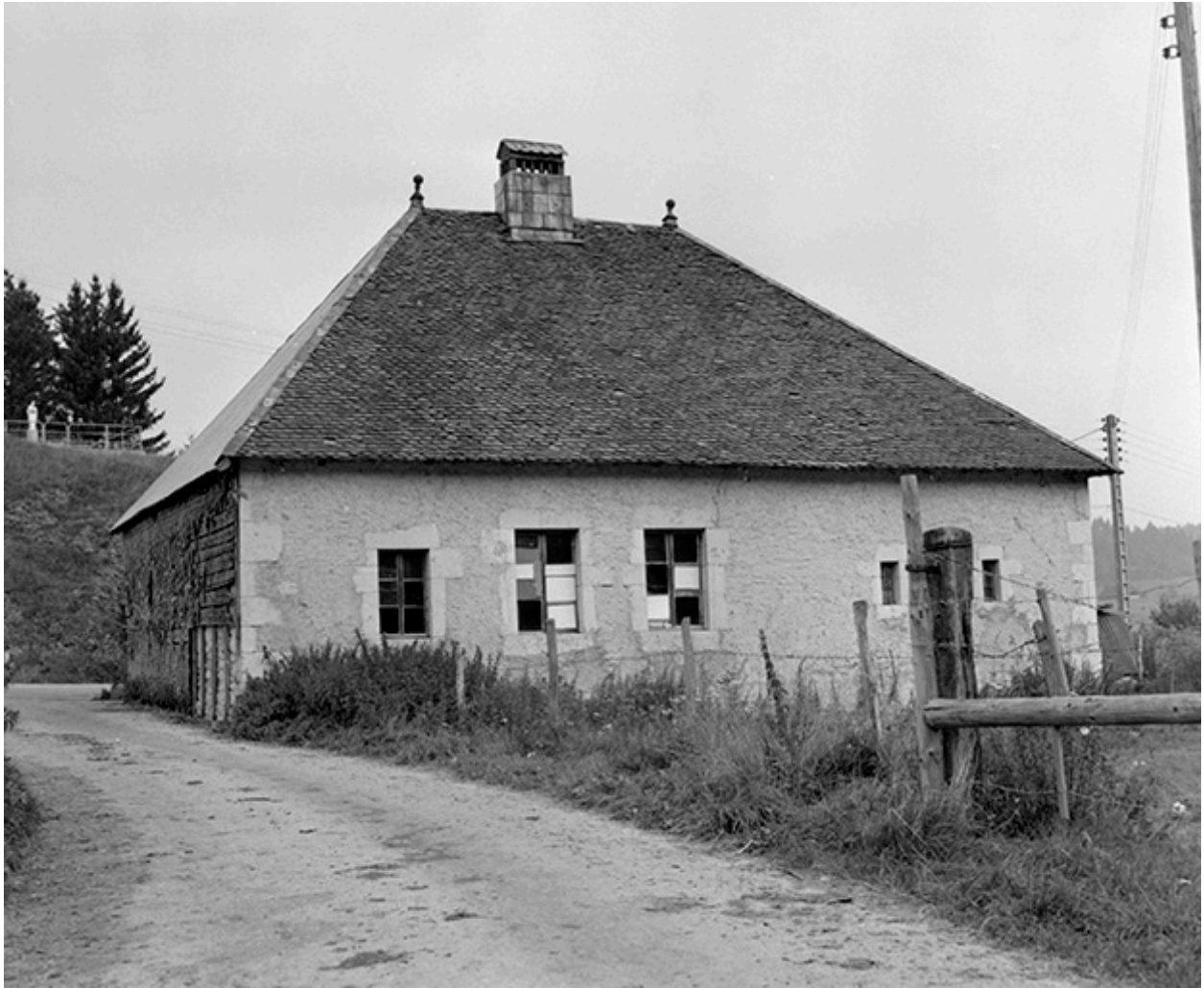
Façades postérieure et latérale droite en 1978. A noter les tavaillons sur la façade latérale.
