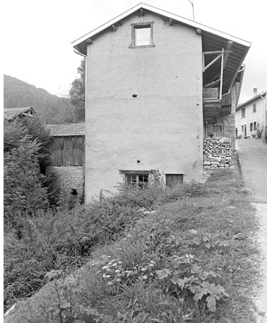
Face gauche de l'atelier de tournerie. Phot. Jérôme Mongreville IVR43_19963901415X
