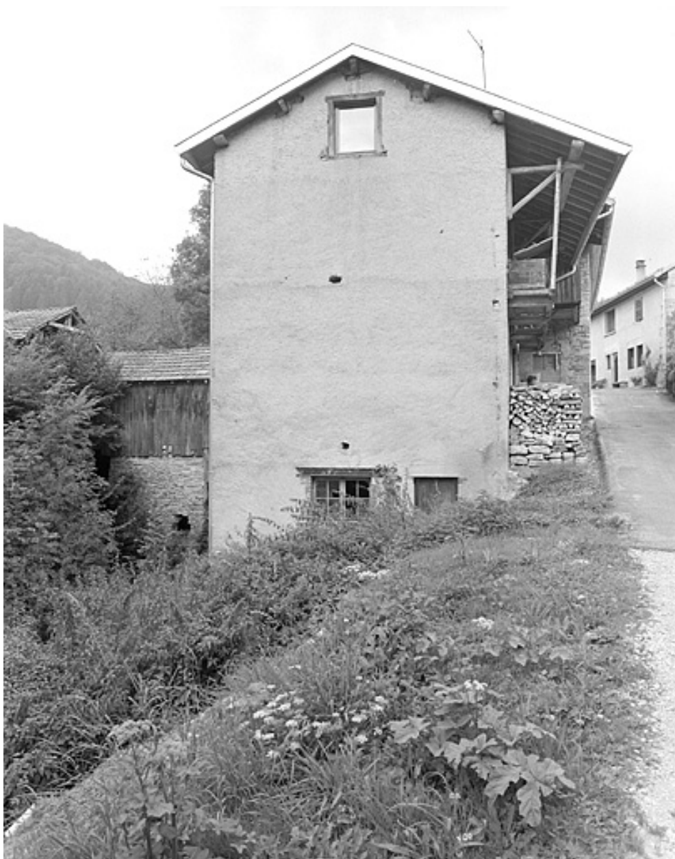
Face gauche de l'atelier de tournerie.
