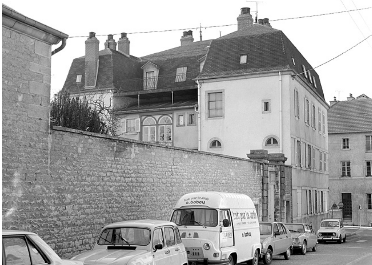
Façades postérieure et latérale gauche.
