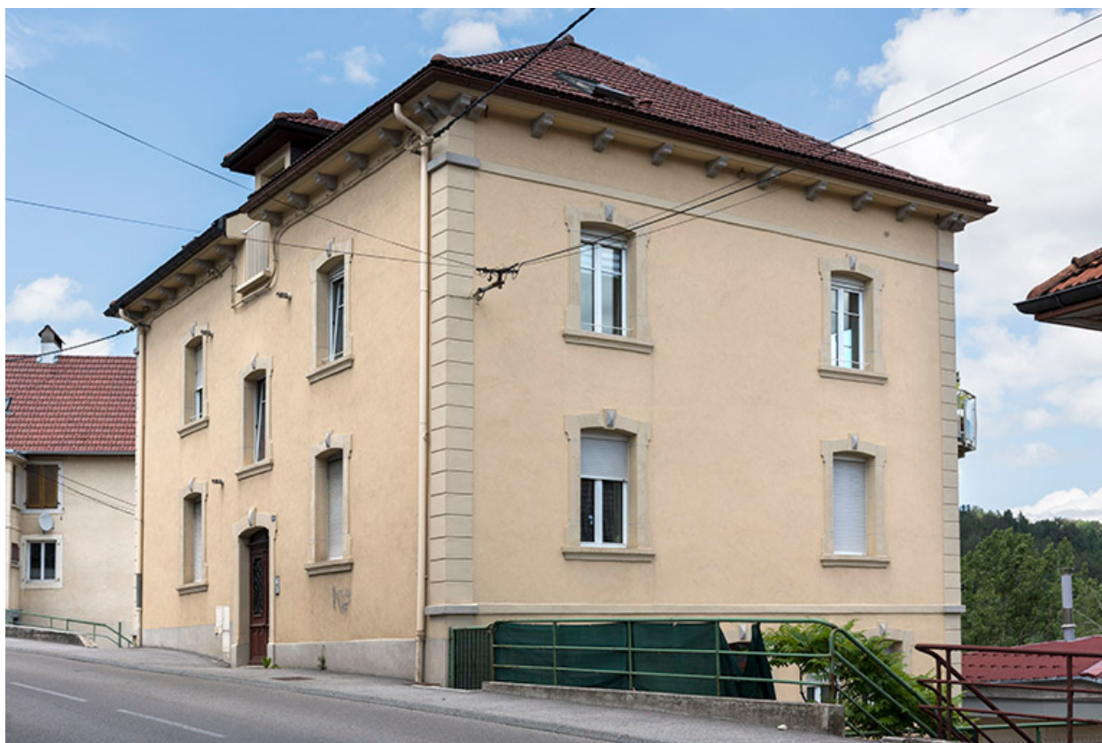
Façades antérieure et latérale droite.
