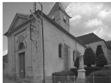
Façade occidentale. Phot. Michel Thierry IVR26_19748900714V
