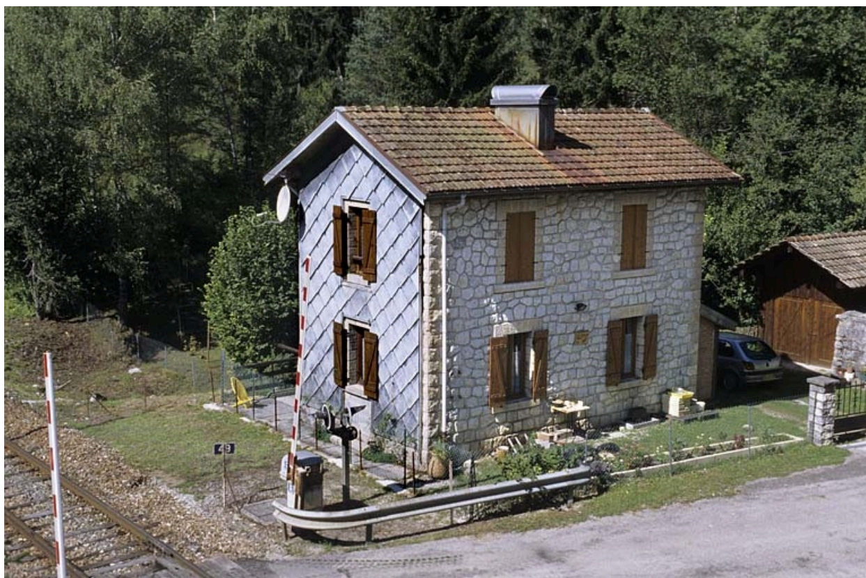
Façades antérieure et latérale gauche (côté voie).
