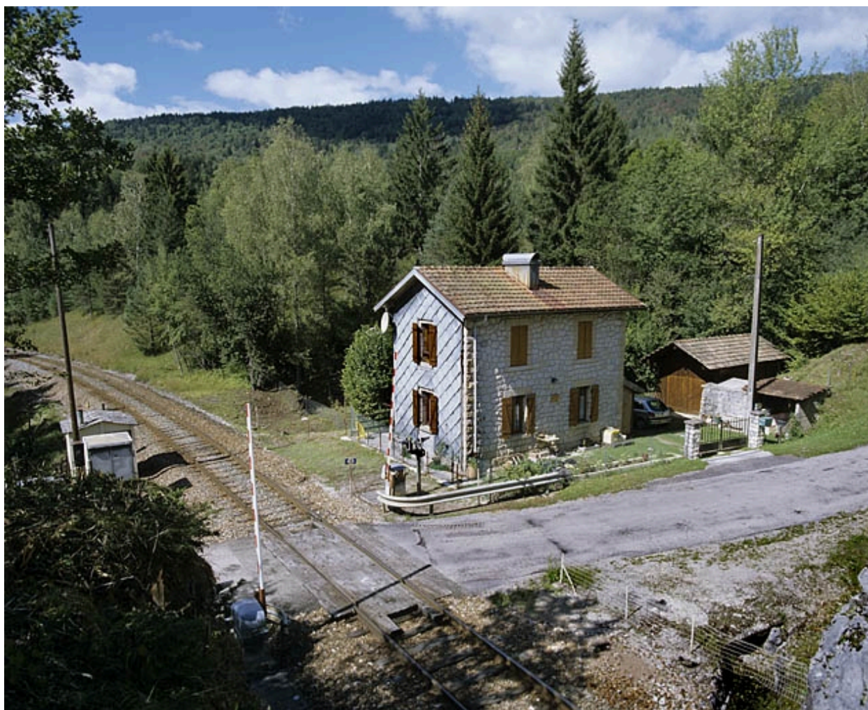
Vue d'ensemble plongeante, depuis le sud-est.
