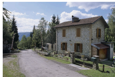
Façades antérieure et latérale droite. Phot. Yves Sancey IVR43_20043900367ZA
