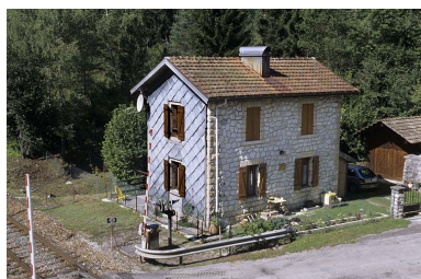
Façades antérieure et latérale gauche (côté voie). Phot. Yves Sancey IVR43_20043900365ZA
