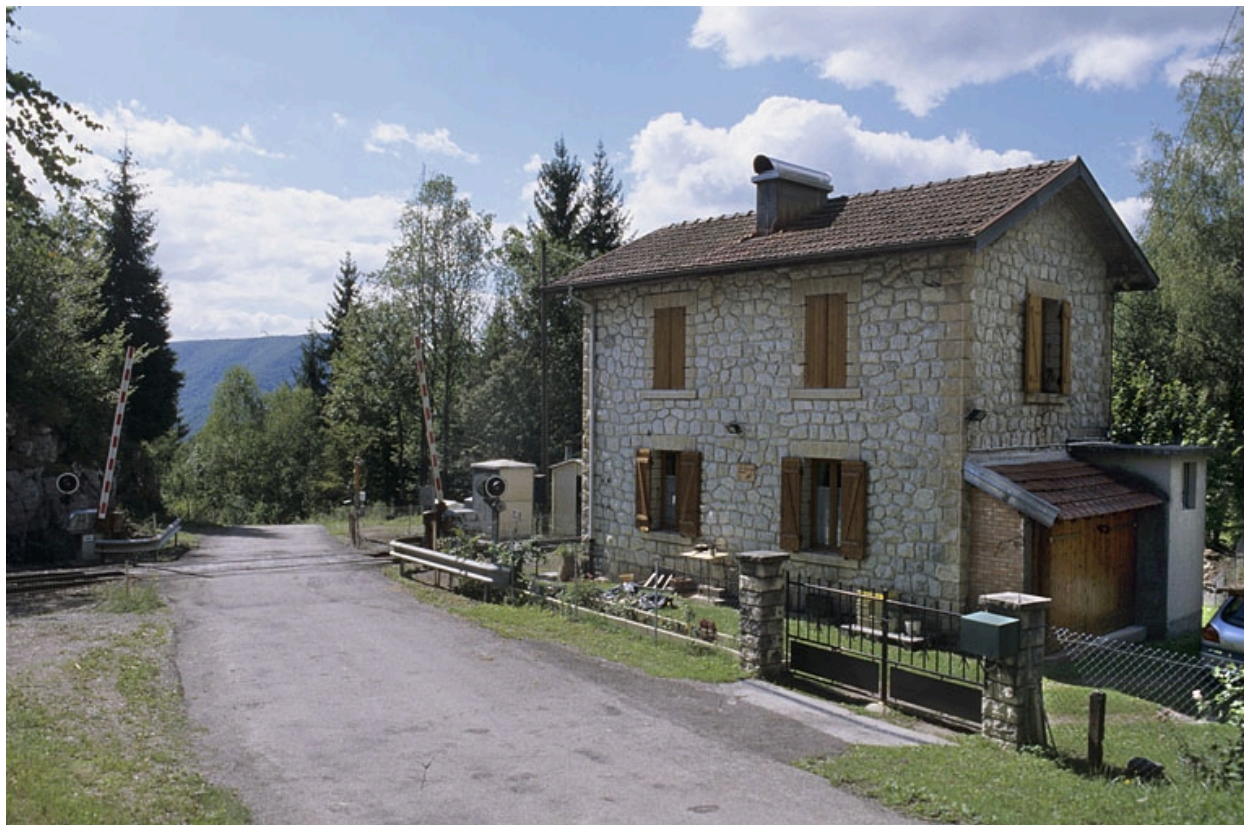
Façades antérieure et latérale droite.
