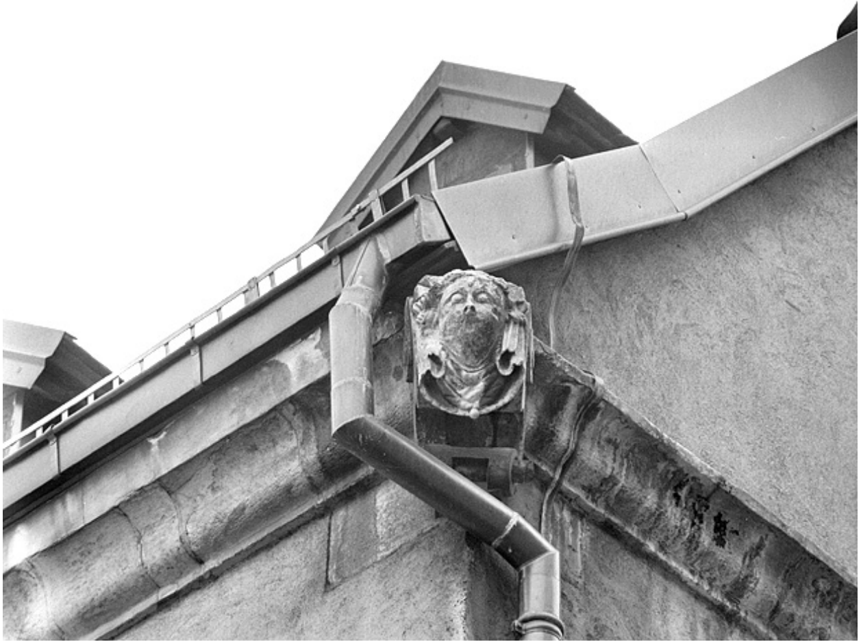
Façade principale. Angle de droite de la corniche.
