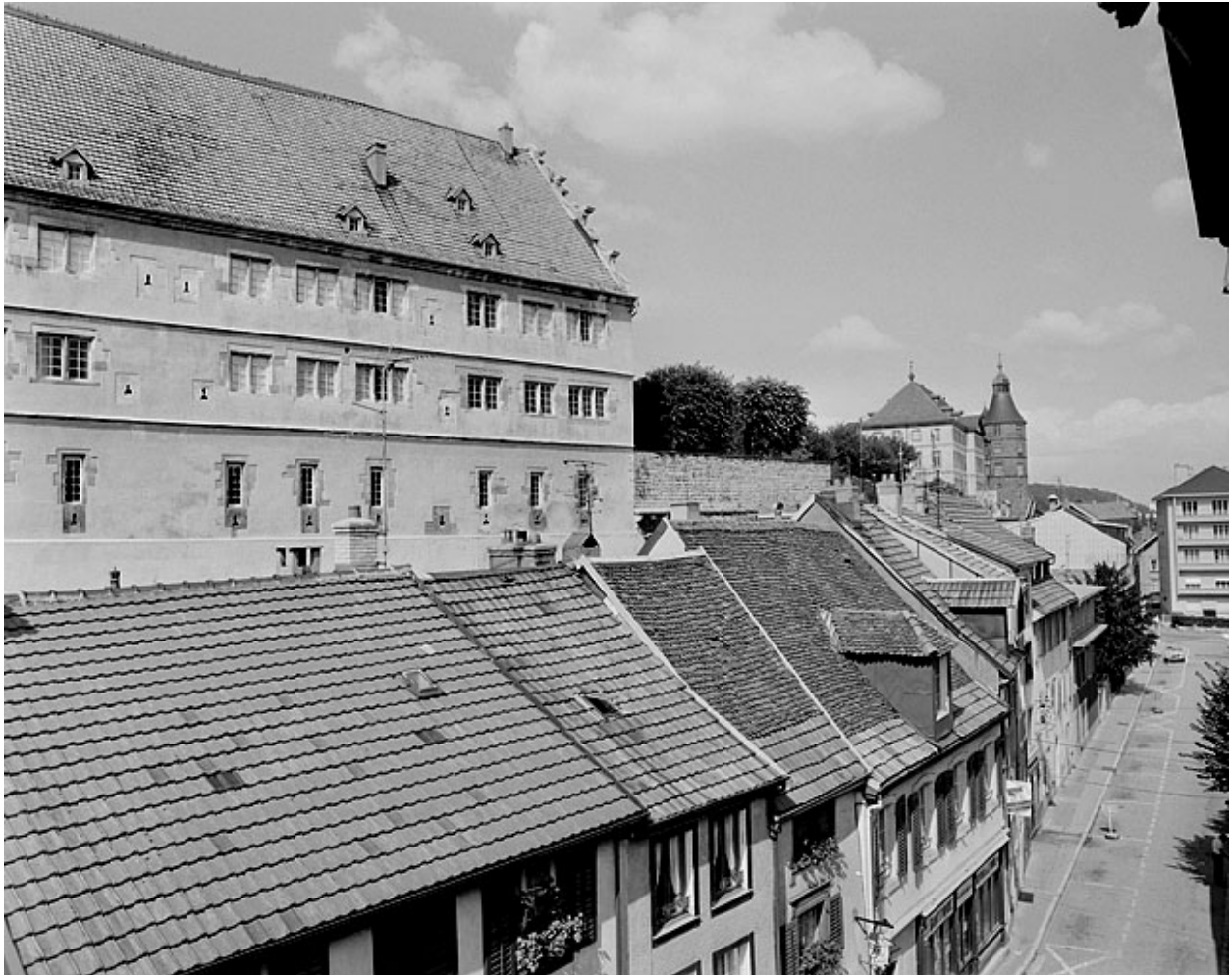
Façade sud et rue de Belfort.
