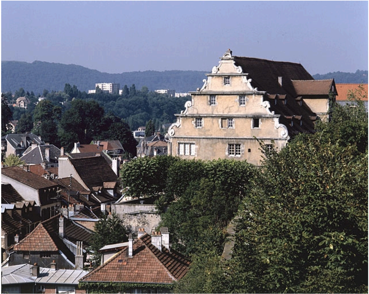
Façade latérale est.
