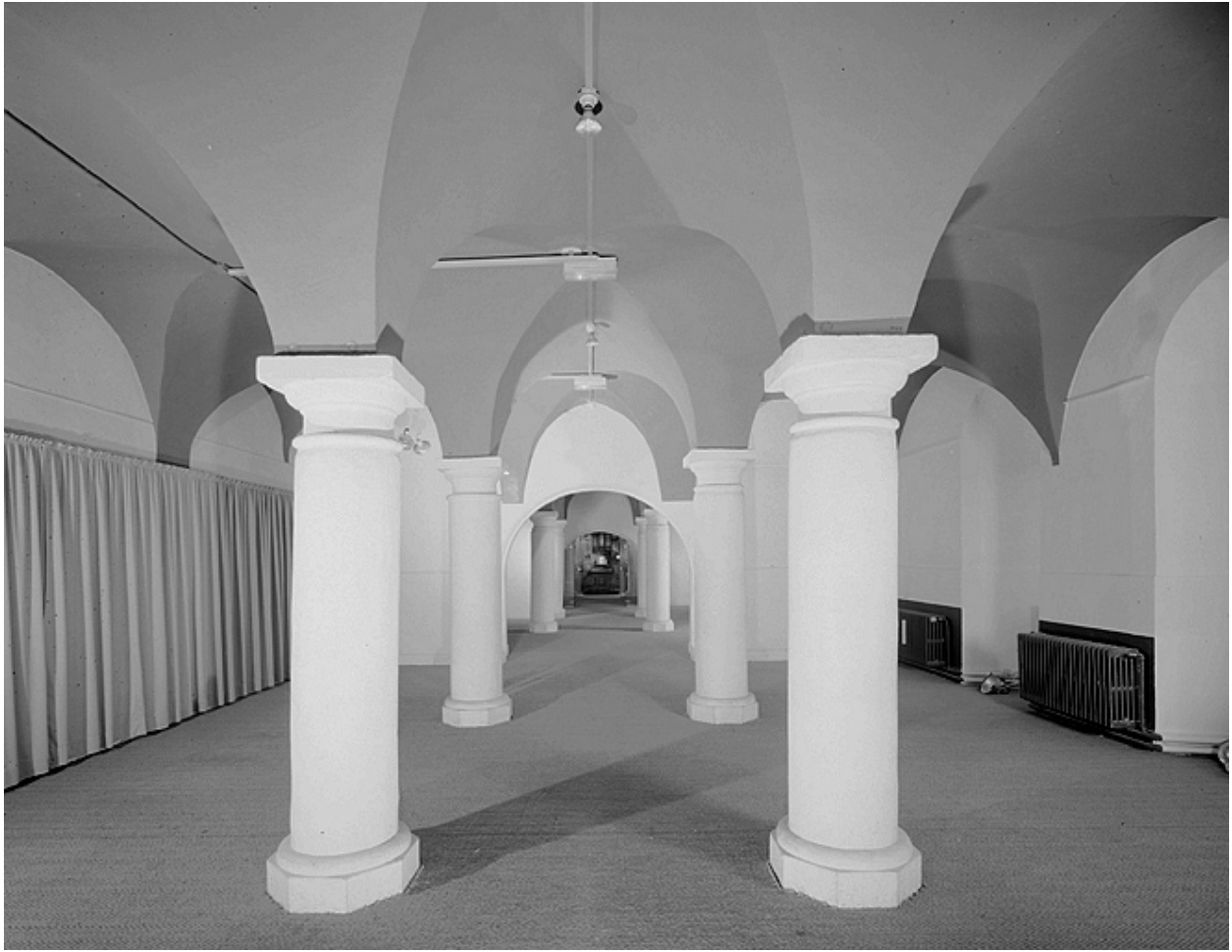
Étage de soubassement. Enfilade des salles côté sud.
