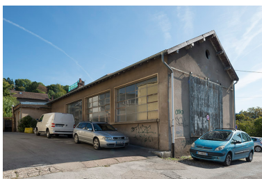
Annexe (atelier ou magasin ?). Phot. Jérôme Mongreville IVR43_20182500514NUC4A
