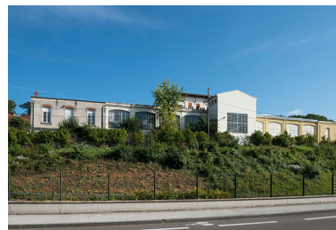
Façades ouest. Phot. Jérôme Mongreville IVR43_20182500510NUC4A
