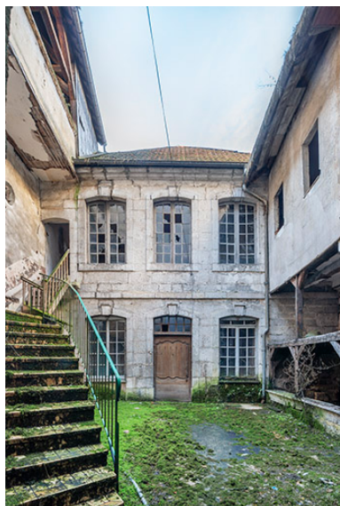
Façade est, depuis la cour.
