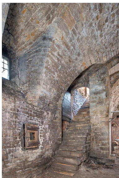
Escalier d'accès à la cave. Phot. Jérôme Mongreville IVR43_20243900036NUC4A
