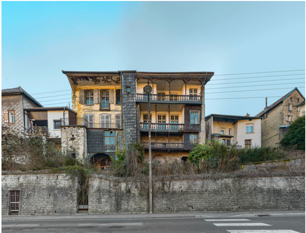
Vue d'ensemble en contre-plongée, depuis l'ouest (façade de gauche).
