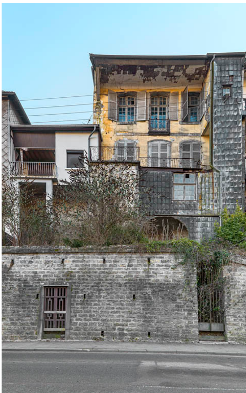
Vue en contre-plongée, depuis l'ouest.
