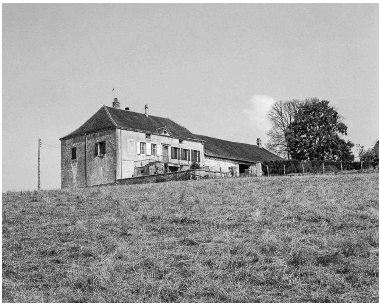
Vue de situation.
