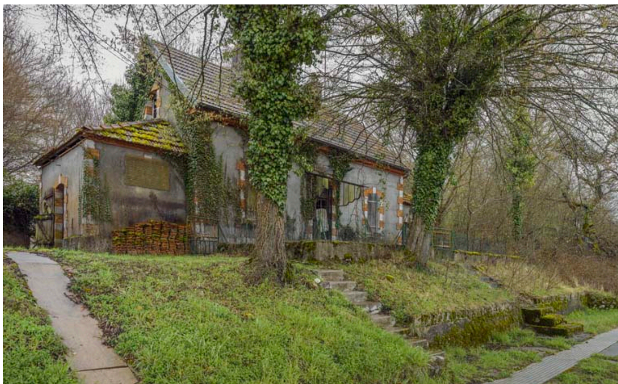
Vue d'ensemble de la maison du barragiste, sur l'île de Fley.
